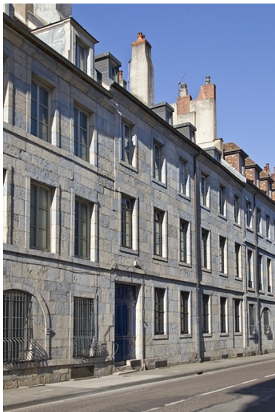
Vue d'ensemble depuis la rue, de trois quarts gauche. 25, Besançon, 6 rue Charles Nodier, lieudit : îlot Préfecture
