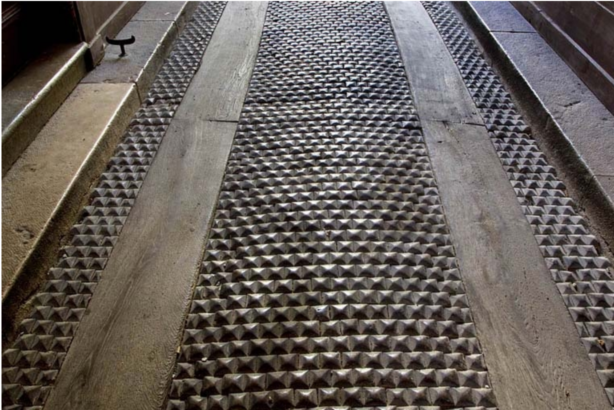
Deuxième logis secondaire, passage cocher : détail des pointes de diamant en bois constituant le sol.
