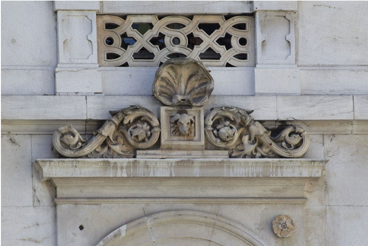
Façade d'angle, premier étage : détail du décor sur l'entablement d'une fenêtre.
