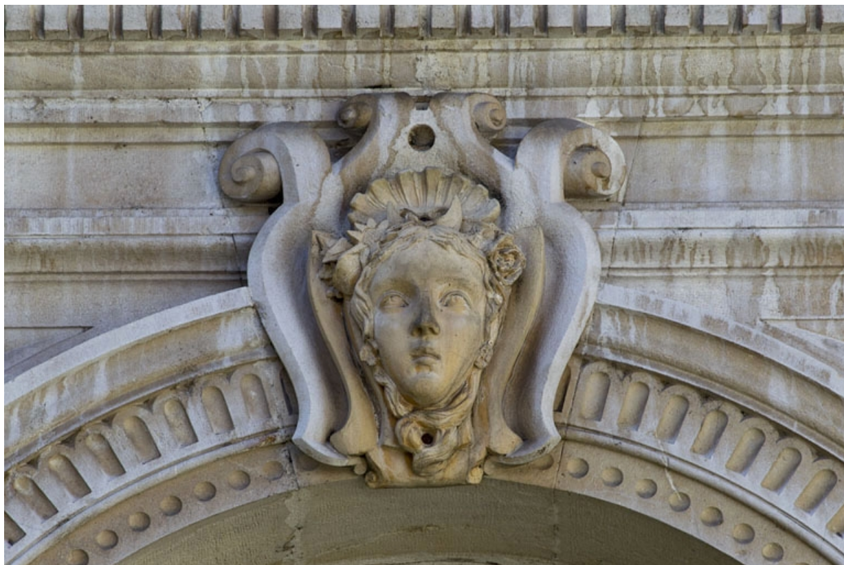
Façade d'angle, rez-de-chaussée, baie centrale, détail du décor de la clé de l'arc : tête de femme.
