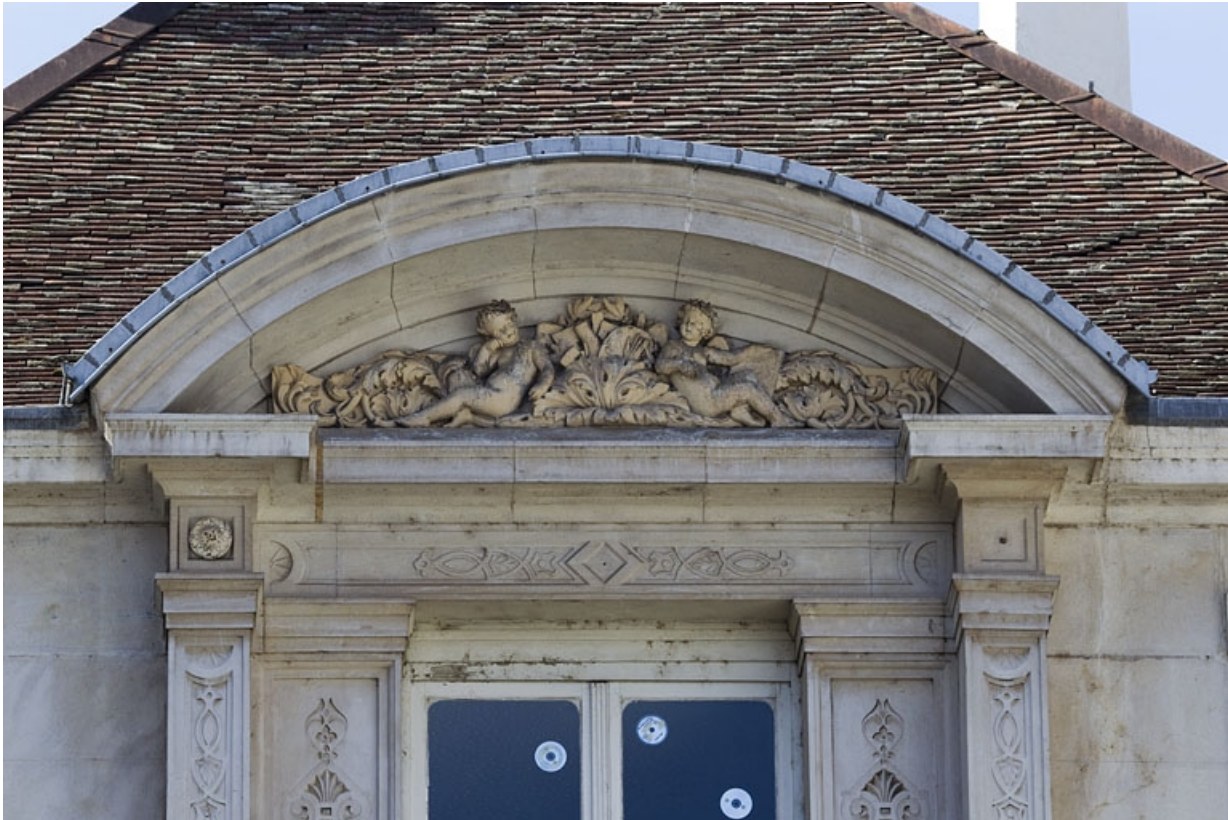
Façade d'angle, deuxième étage, baie centrale : détail du décor du fronton.
