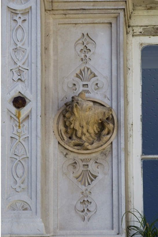
Façade d'angle, deuxième étage, baie centrale, détail du décor gauche : tête de sanglier. 25, Besançon, 2 rue Lecourbe, lieudit : îlot Lecourbe
