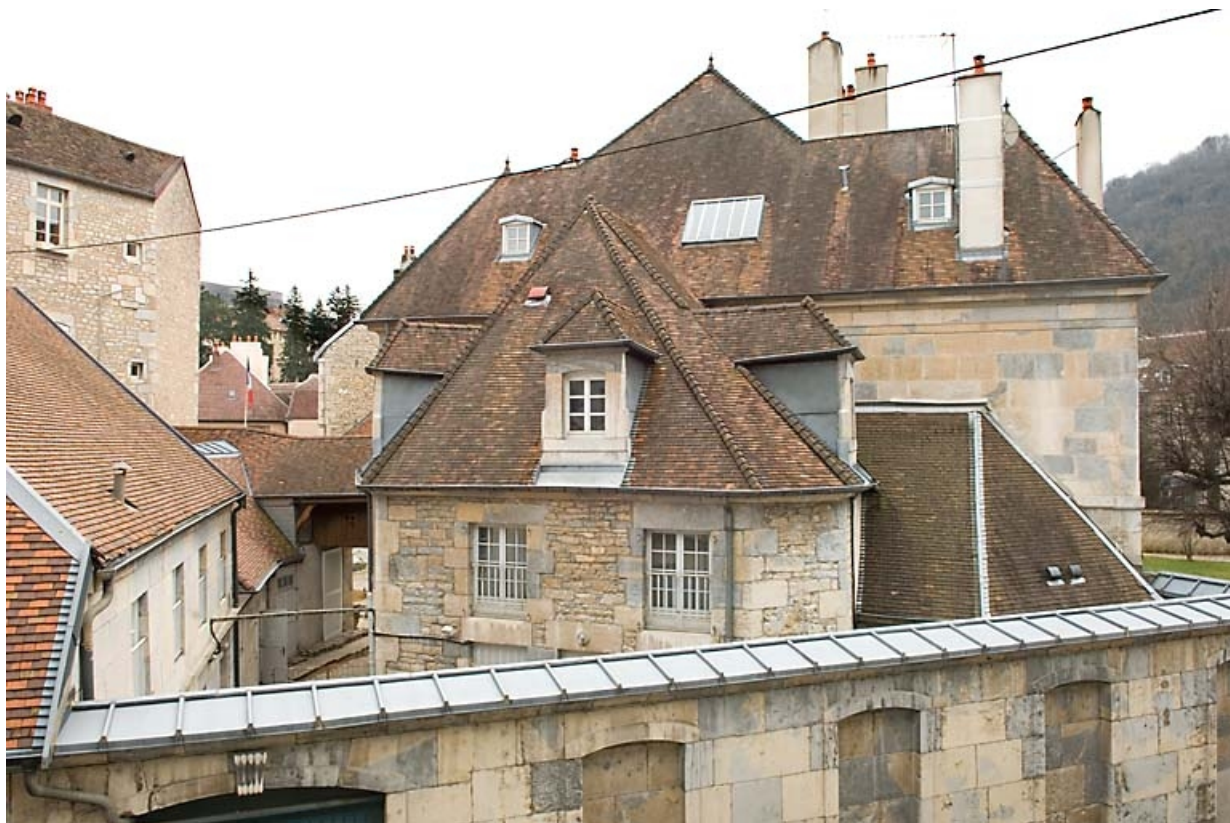
Vue d'ensemble des façades latérales depuis le balcon de l'hôtel de Courbouzon, situé rue Chifflet.
