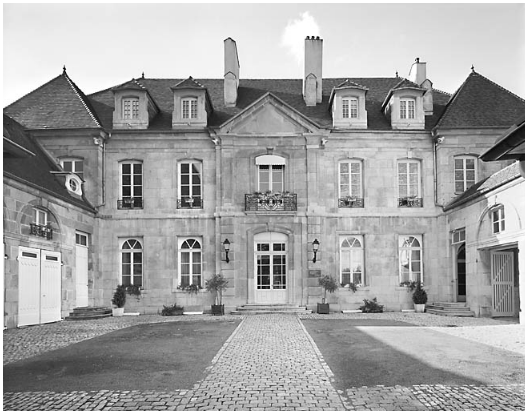
Vue d'ensemble du logis sur cour, depuis le portail d'entrée.
