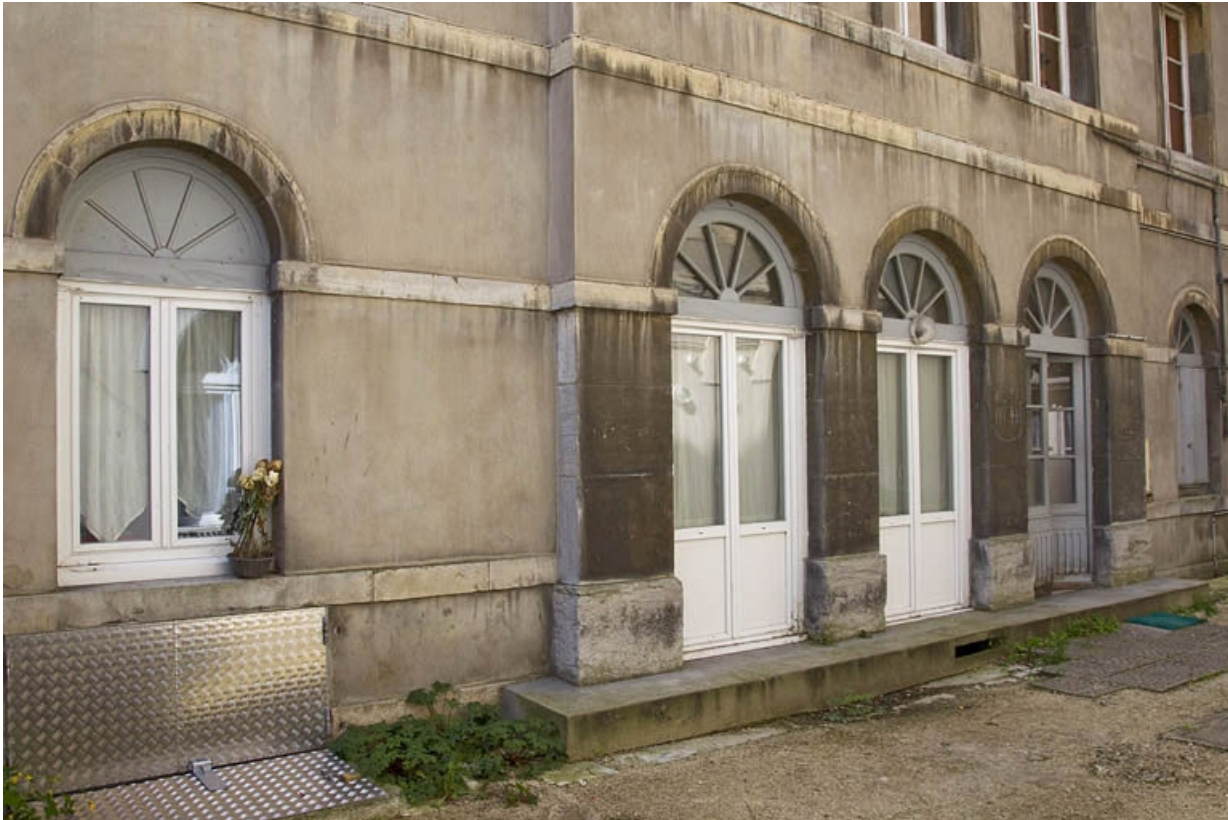
Logis principal, façade antérieure, détail du rez-de-chaussée : de trois quarts gauche. 25, Besançon, 12 rue Lecourbe, lieudit : îlot Lecourbe
