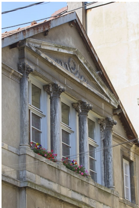
Logis principal, deuxième étage, partie centrale : détail des colonnes supportant le fronton, de trois quarts gauche. 25, Besançon, 12 rue Lecourbe, lieudit : îlot Lecourbe
