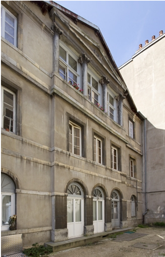
Façade antérieure du logis principal : de trois quarts gauche.
