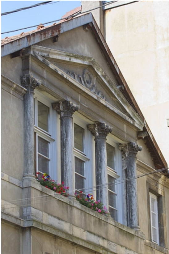
Logis principal, deuxième étage, partie centrale : détail des colonnes supportant le fronton, de trois quarts gauche. 25, Besançon, 12 rue Lecourbe, lieudit : îlot Lecourbe
