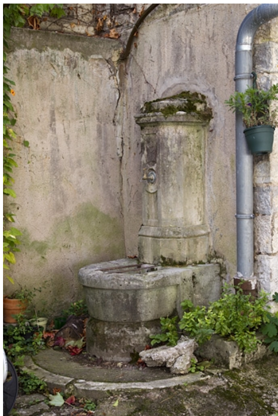
Vue d'ensemble de la borne fontaine située dans la cour. 25, Besançon, 2 rue de la Vieille Monnaie, lieudit : îlot Refuge
