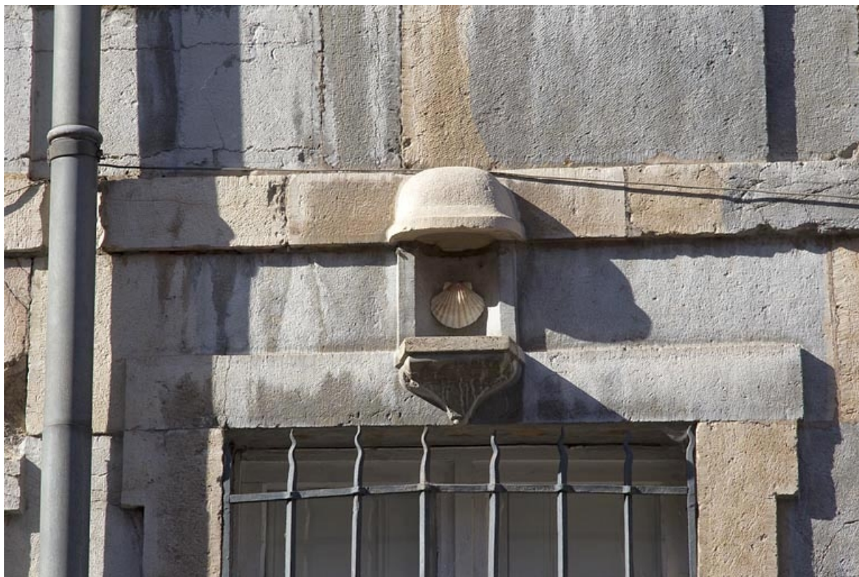
Logis principal, façade antérieure : détail d'une niche au-dessus d'une fenêtre du rez-de-chaussée. 25, Besançon, 2 rue de la Vieille Monnaie, lieudit : îlot Refuge
