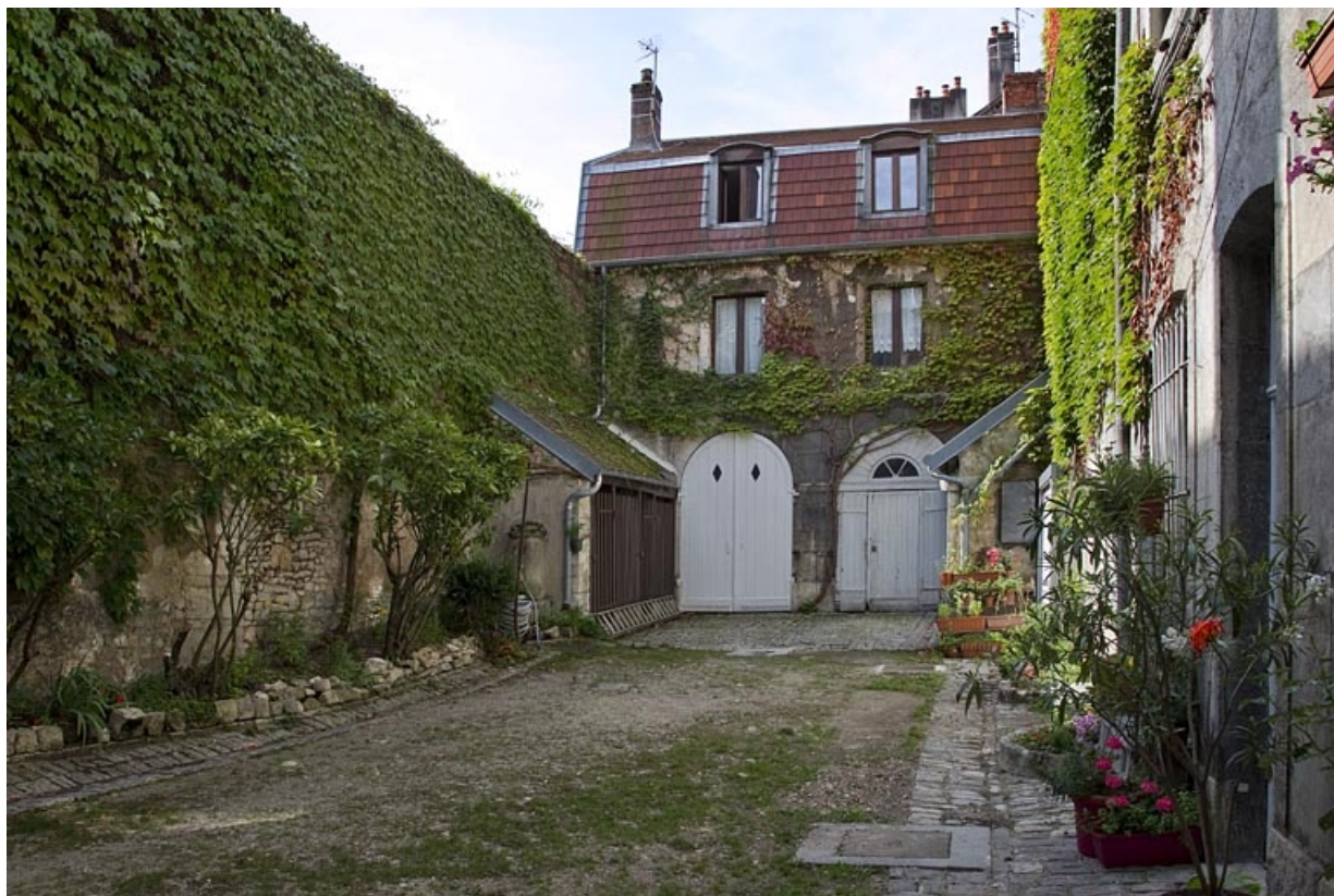
Deuxième logis secondaire : vue d'ensemble depuis l'entrée de la cour.
