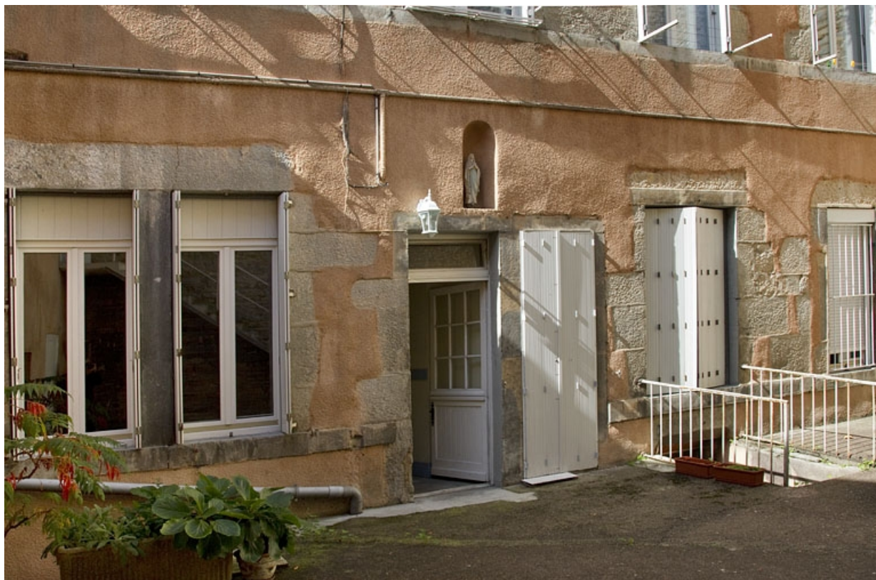
Logis principal, façade postérieure : détail du rez-de-chaussée, de trois quarts gauche.
