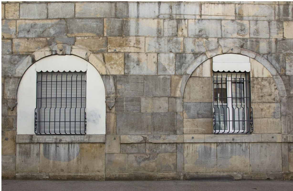
Logis principal, façade antérieure, rez-de-chaussée : détail des arcades boutiquières murées.
