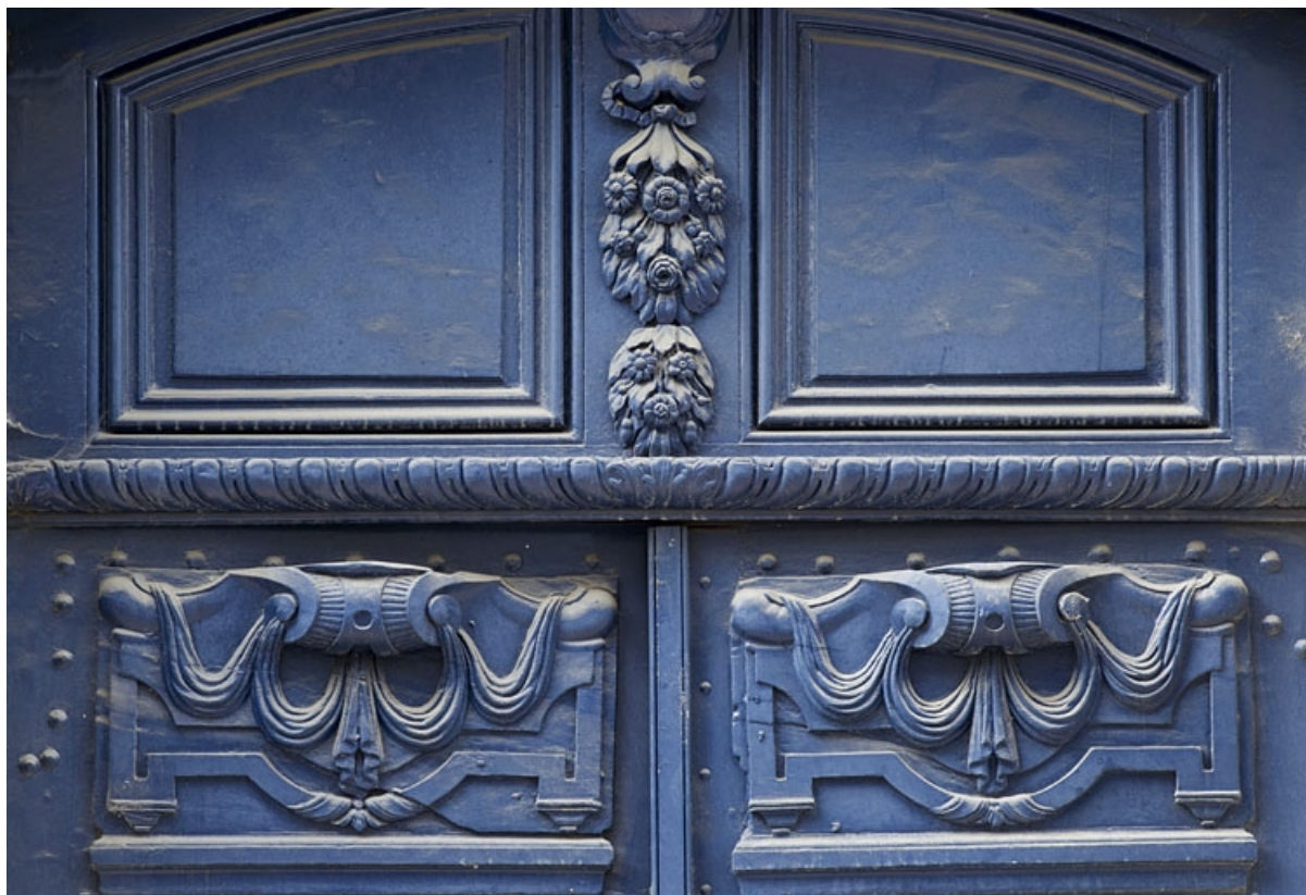
Logis principal, façade antérieure, portail d'entrée : détail du décor des vantaux de la porte. 25, Besançon, 4 rue de la Vieille Monnaie, lieudit : îlot Refuge
