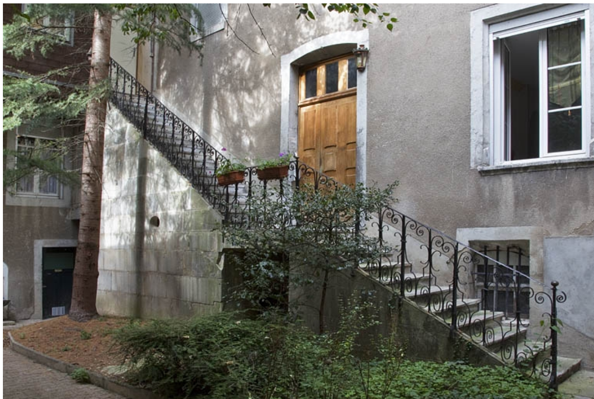
Premier logis secondaire : détail de l'escalier extérieur, de trois quarts gauche.
