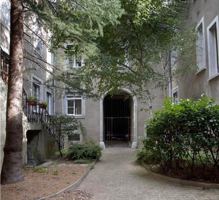
Logis principal, façade postérieure depuis le fond de la cour. 25, Besançon, 4 rue de la Vieille Monnaie, lieudit : îlot Refuge
