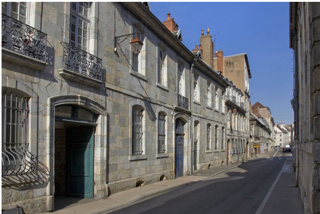
Vue d'ensemble depuis la rue, de trois quarts gauche, vue rapprochée.
