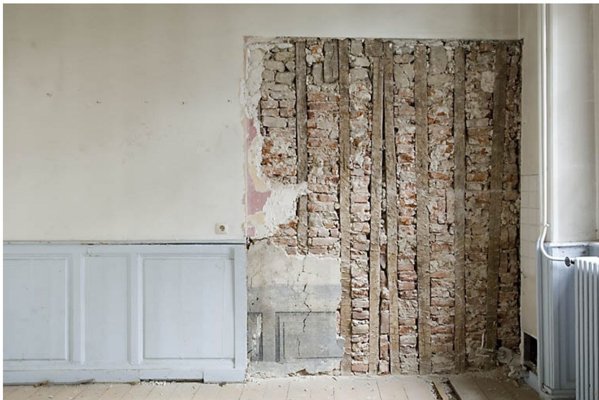
Détail d'une peinture murale sous un lambris d'appui dans une pièce du premier étage. 25, Besançon, 4 rue de la Vieille Monnaie, lieudit : îlot Refuge
