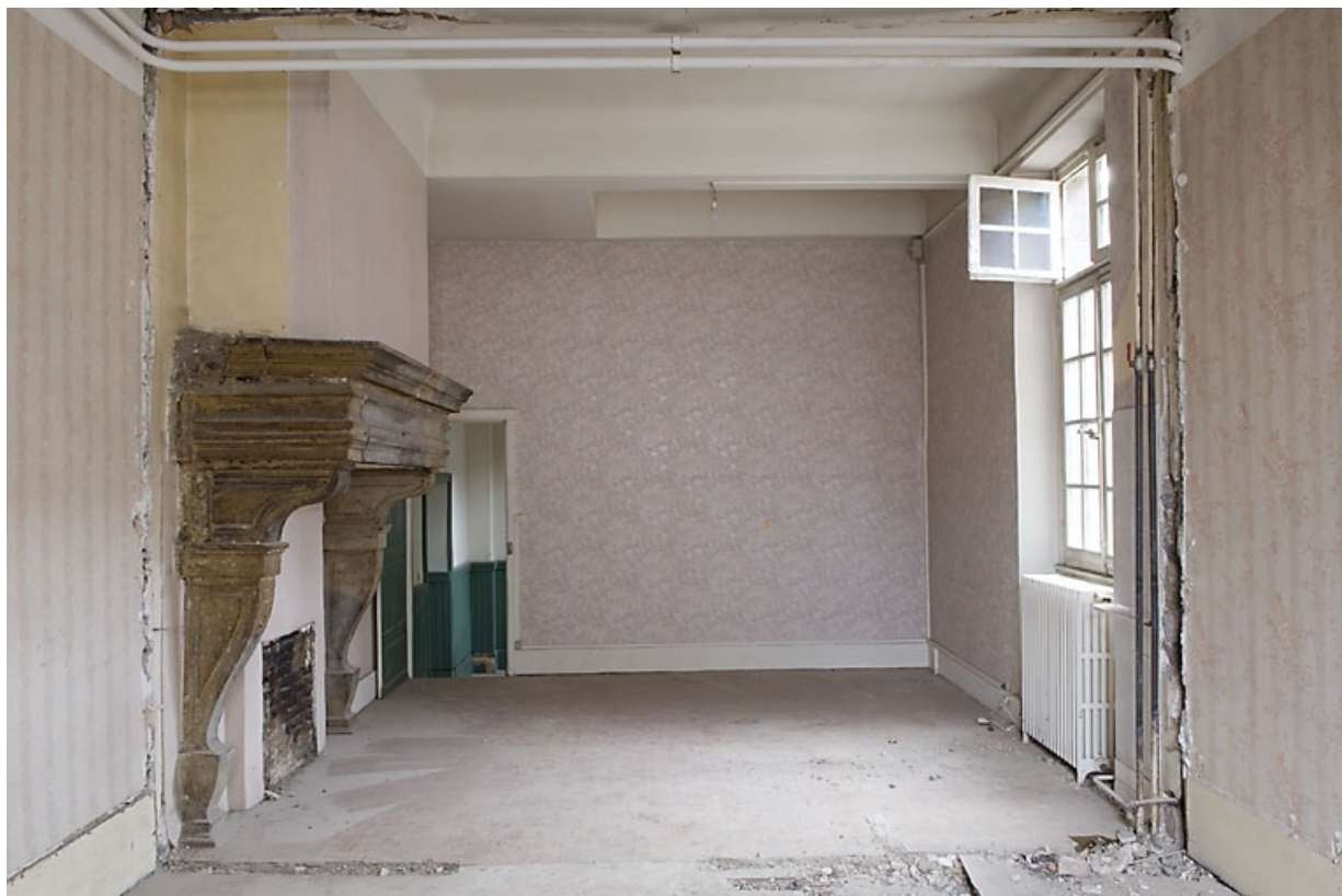
Vue d'ensemble d'une cheminée d'une pièce du premier étage.
