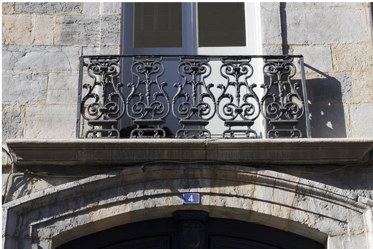
Logis principal, façade antérieure : détail du garde-corps du balcon.
