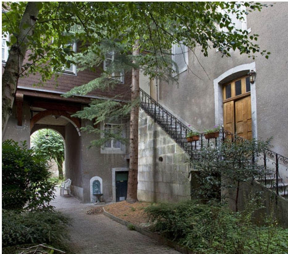
Vue d'ensemble de l'escalier extérieur du premier logis secondaire.
