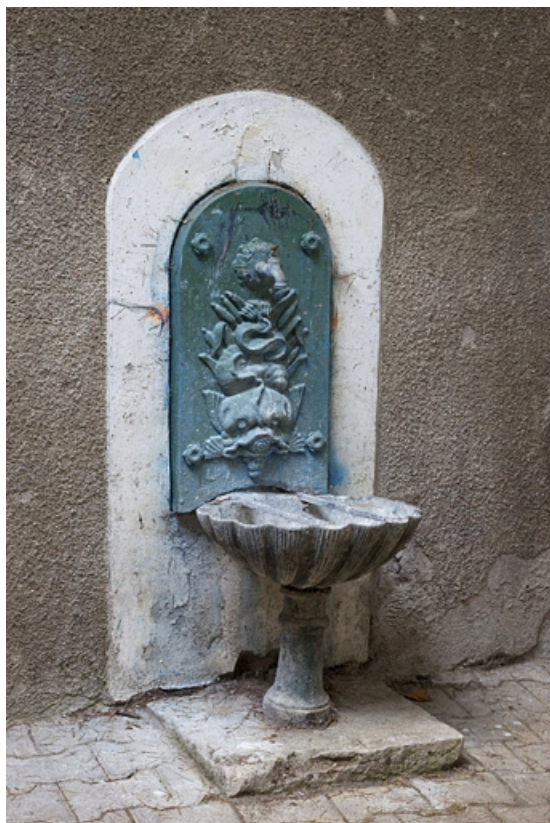
Vue d'ensemble de la borne fontaine située dans la cour. 25, Besançon, 4 rue de la Vieille Monnaie, lieudit : îlot Refuge
