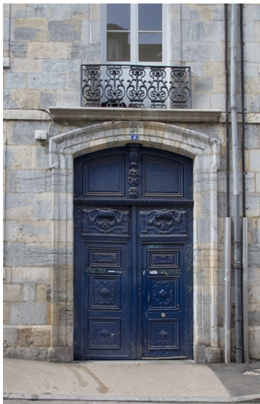
Logis principal, façade antérieure : détail du portail d'entrée.
