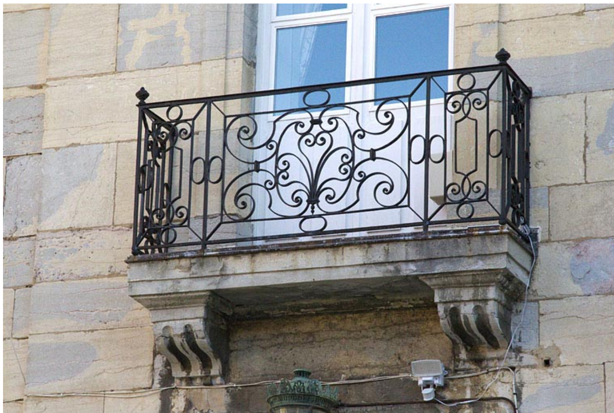
Façade antérieure, partie centrale : détail du balcon.
