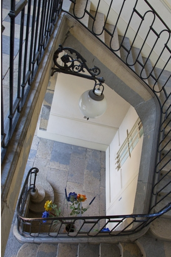
Intérieur, escalier d'honneur : vue en plongée. 25, Besançon, 7 rue Lecourbe, lieudit : îlot Refuge
