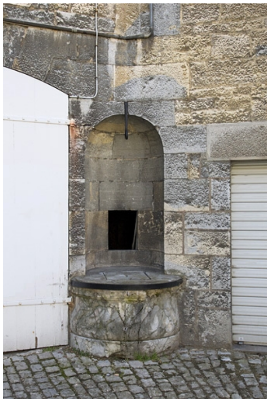
Détail du puits situé dans la cour antérieure.
