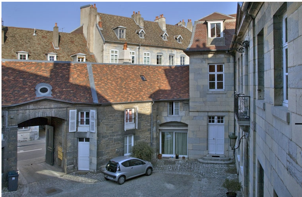
Détail d'une partie de la cour antérieure, en plongée.
