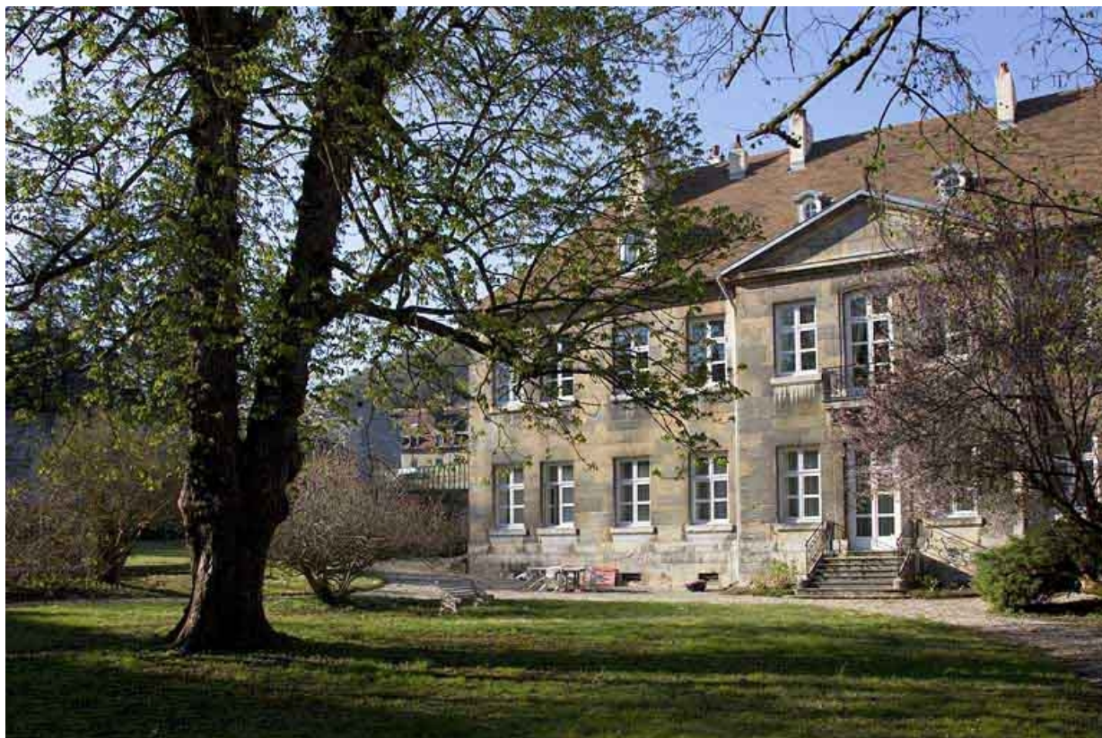
Vue de la partie gauche de la façade postérieure, depuis le fond du jardin : de trois quarts droit.
