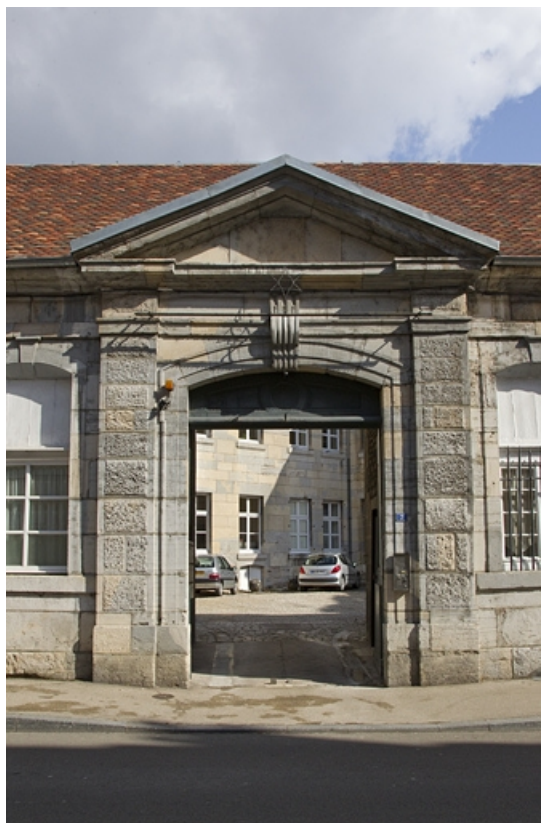
Vue du portail dans clôture : de face.
