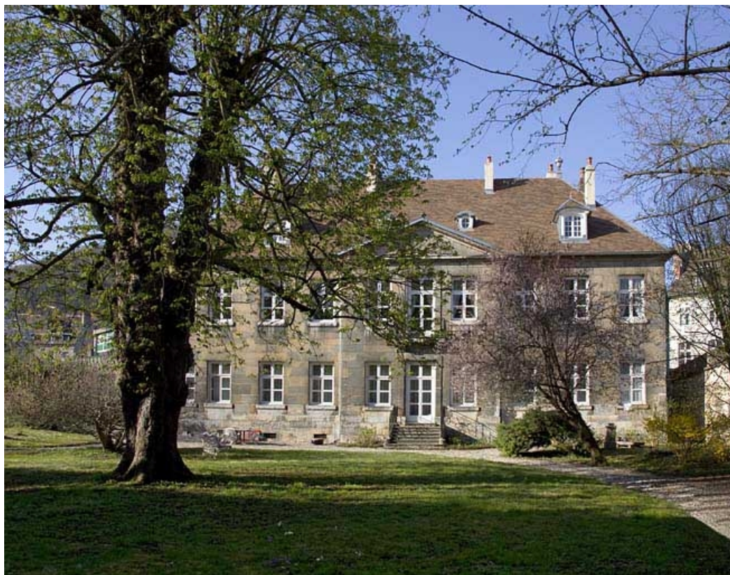
Vue d'ensemble de la façade postérieure depuis le fond du jardin.
