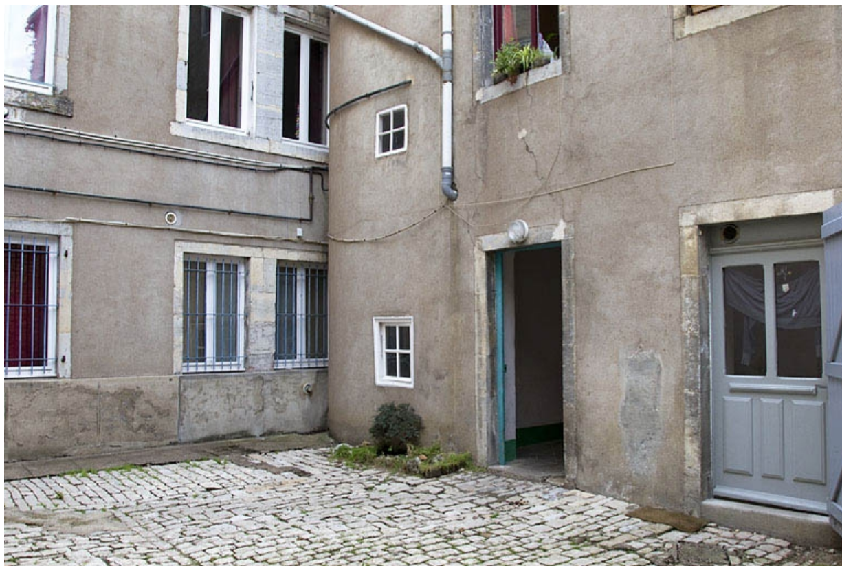
Deuxième logis secondaire : détail du rez-de-chaussée, de trois quarts droit.
