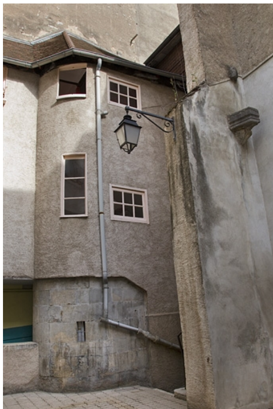
Escalier à cage ouverte : détail de la partie droite depuis la cour.
