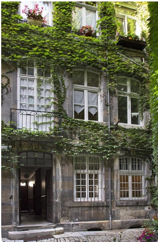
Logis principal, façade postérieure : de face. 25, Besançon, 1 rue Lecourbe, lieudit : îlot Refuge
