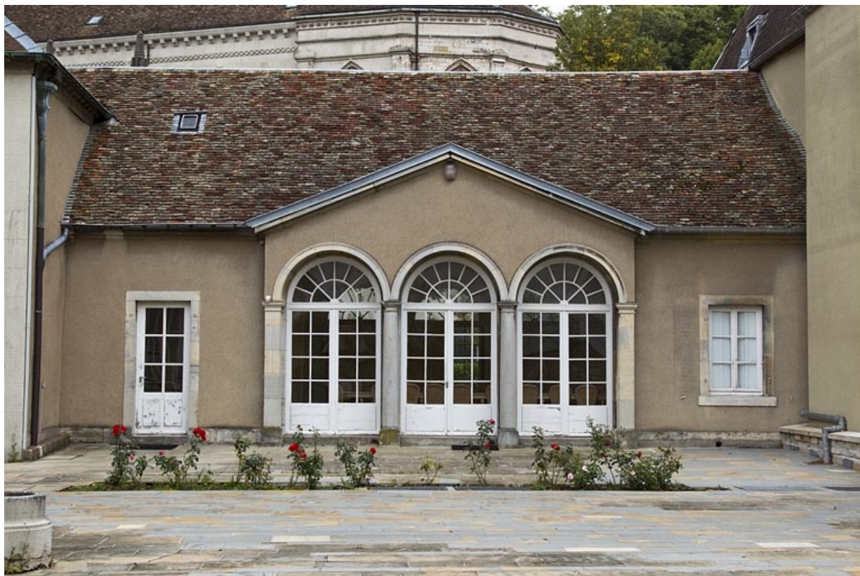
Orangerie : vue d'ensemble de la façade antérieure.
