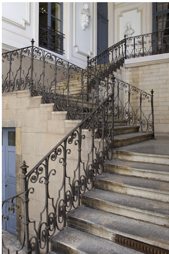
Escalier : vue d'ensemble de la rampe en ferronnerie.
