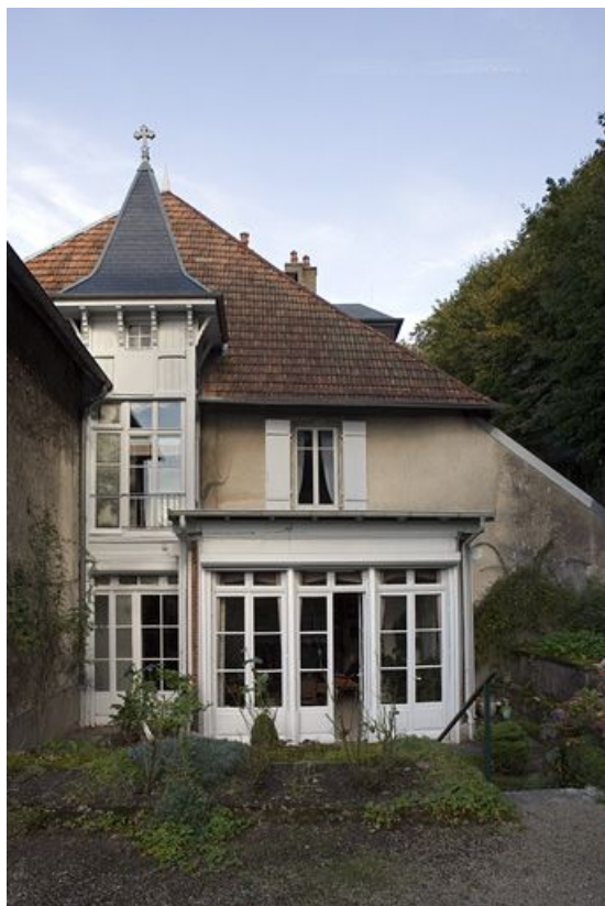
Façade latérale droite : vue rapprochée de face.
