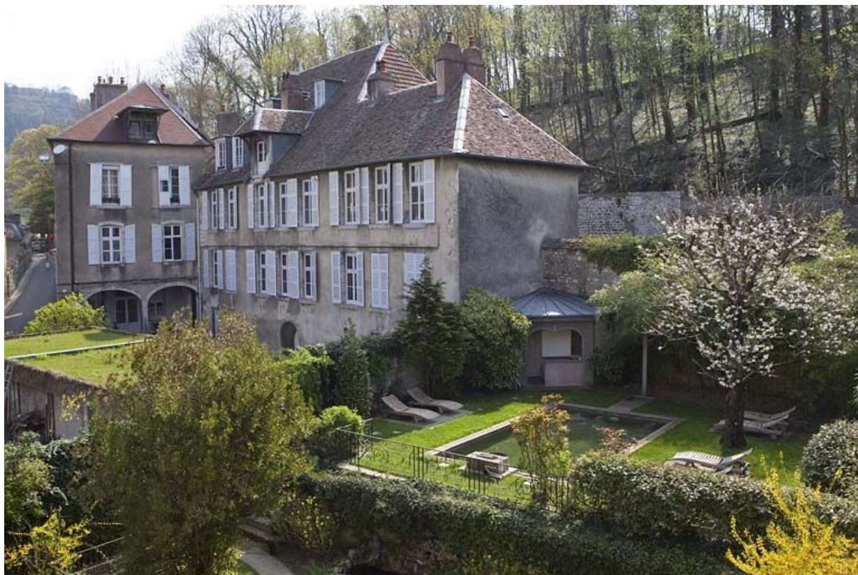
Vue d'ensemble de l'édifice de trois quarts droit, depuis le jardin voisin.
