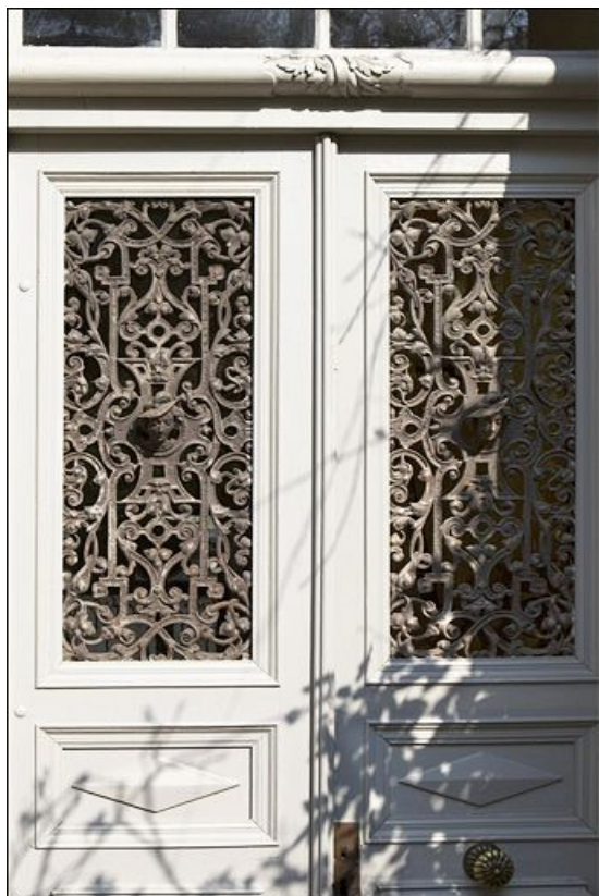
Détail du décor en fonte des deux panneaux de la porte d'entrée.
