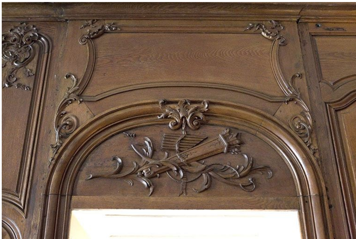
Lambris du salon : détail d'un dessus de porte.
