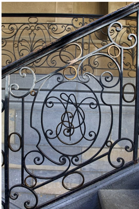
Aile de l'escalier : détail d'un motif de la rampe d'escalier.
