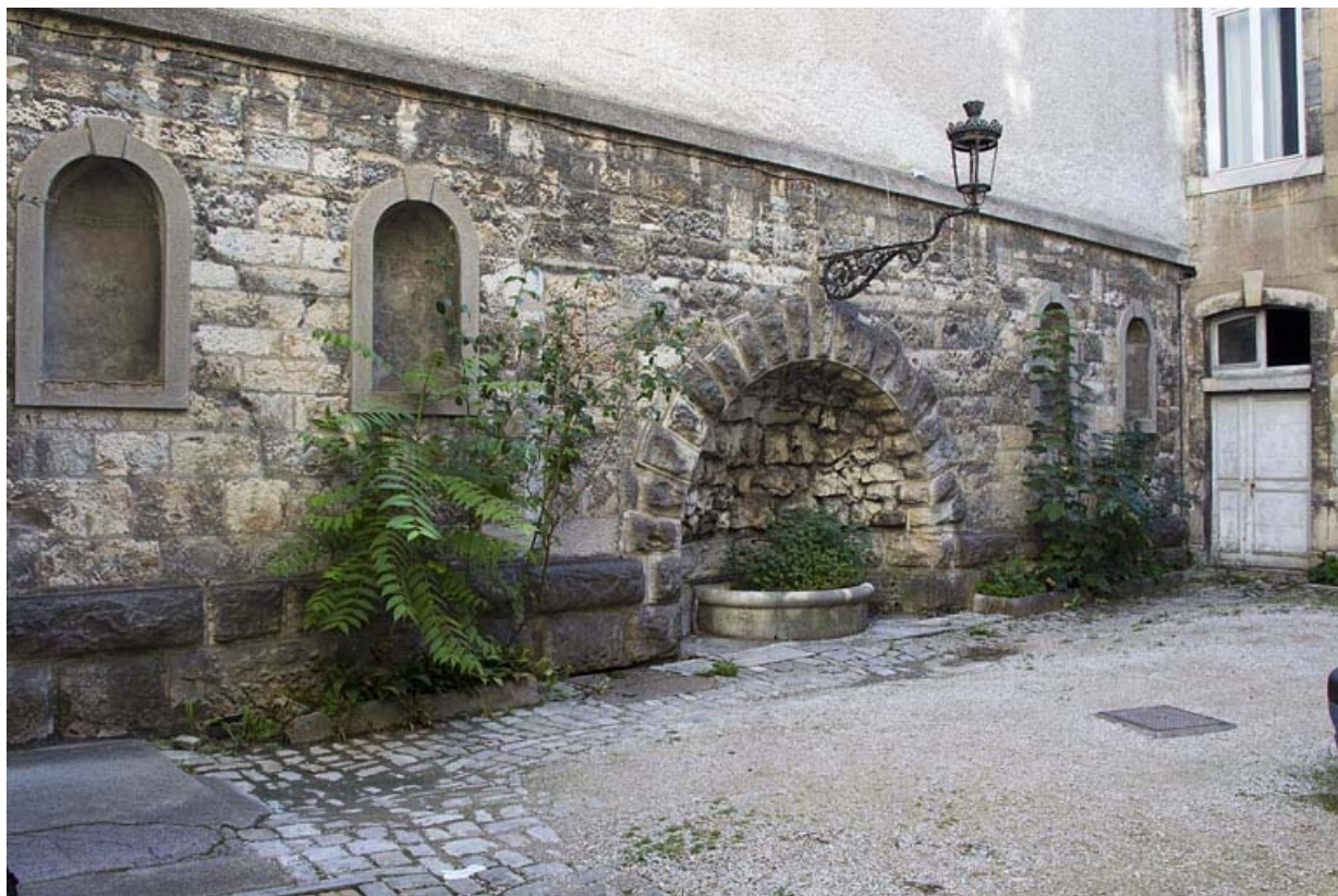
Mur gauche de la cour : vue d'ensemble.
