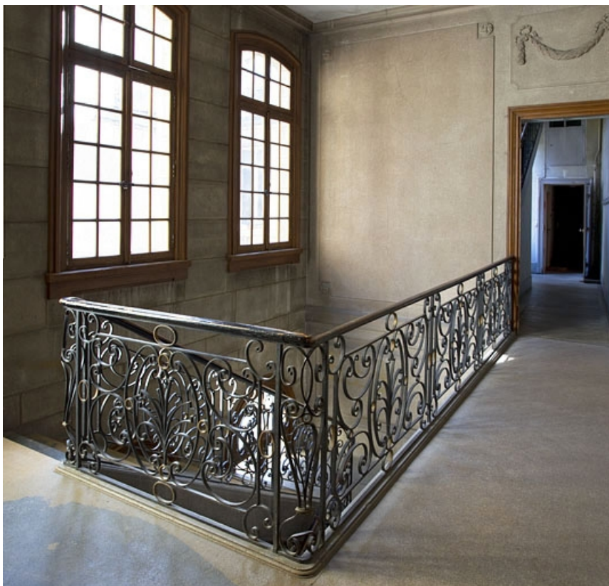
Logis principal : détail de la rampe en ferronnerie de l'escalier.
