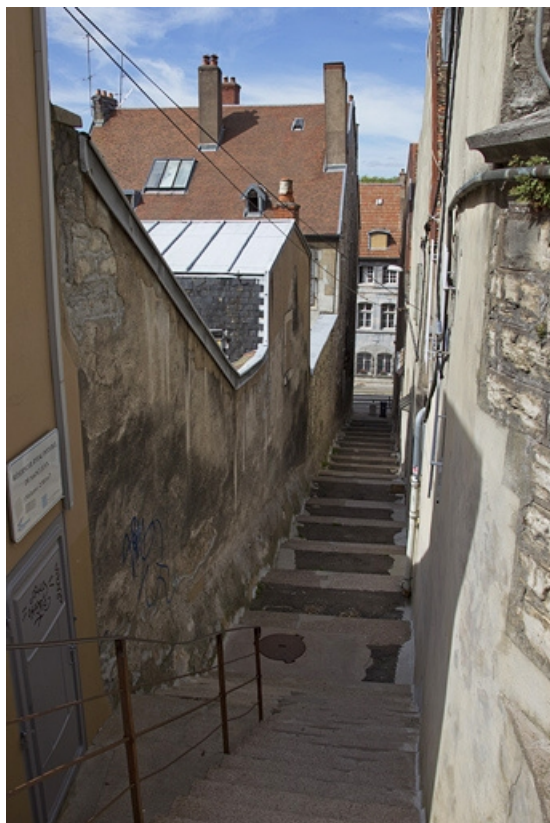
Façade latérale gauche de l'édifice longeant la ruelle Casenat, depuis le haut de la ruelle. 25, Besançon, 25 rue Renan, lieudit : îlot Cingle
