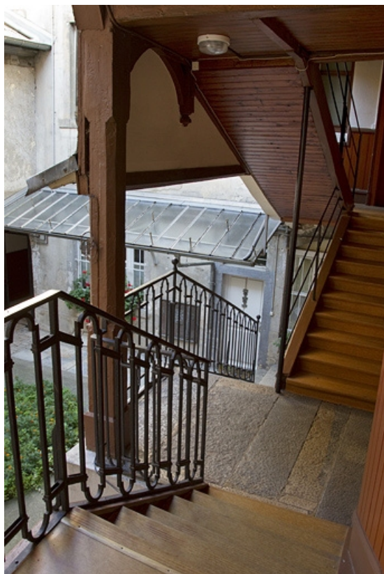
Escalier à cage ouverte : vue depuis l'intérieur.
