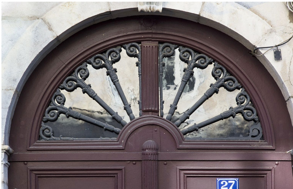
Portail d'entrée : détail du tympan en menuiserie de la porte.
