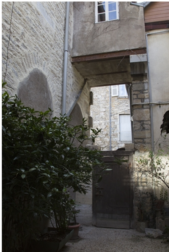
Détail de la courette débouchant sur la cour principale.
