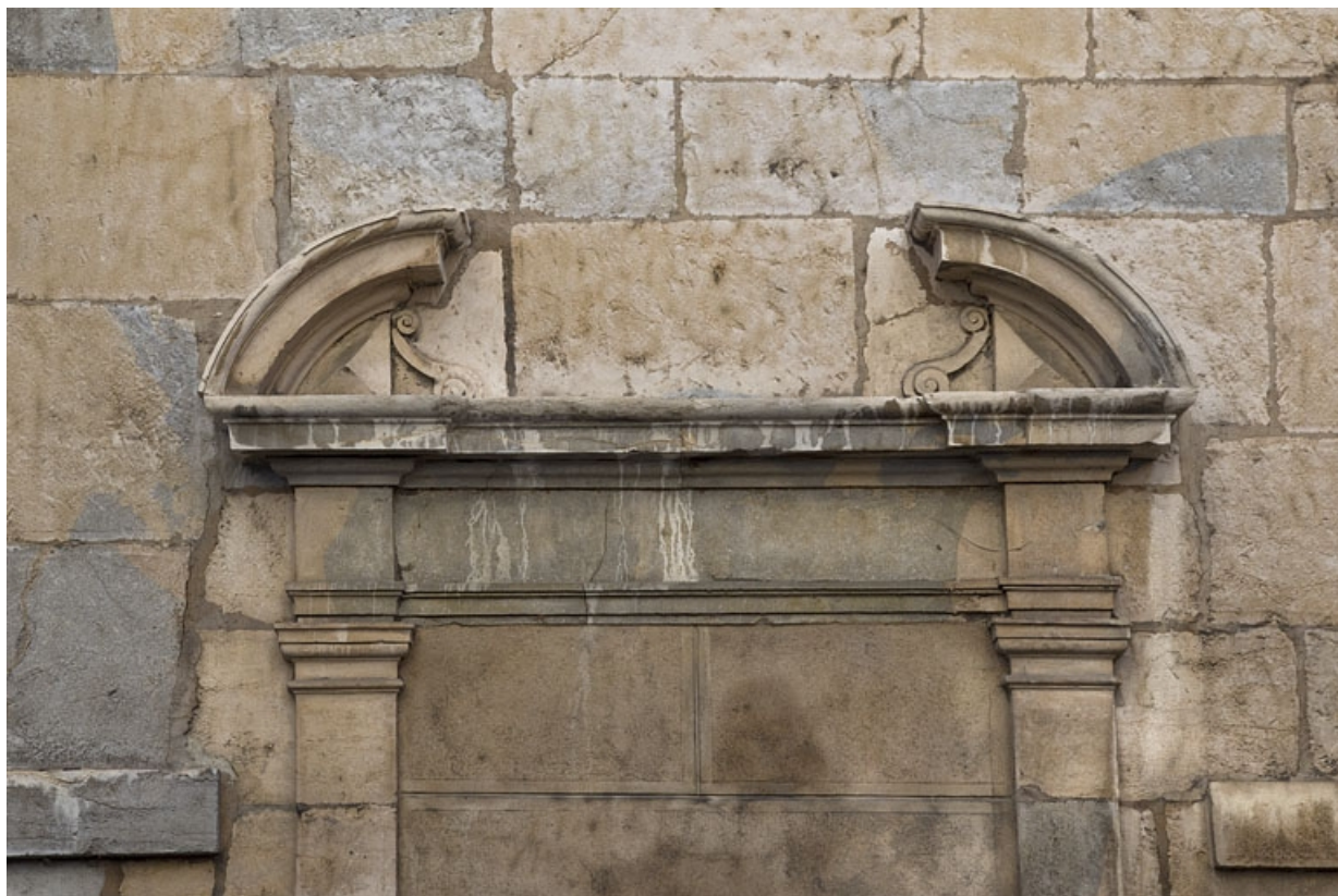
Premier logis secondaire, façade antérieure : détail du fronton interrompu de la porte murée.
