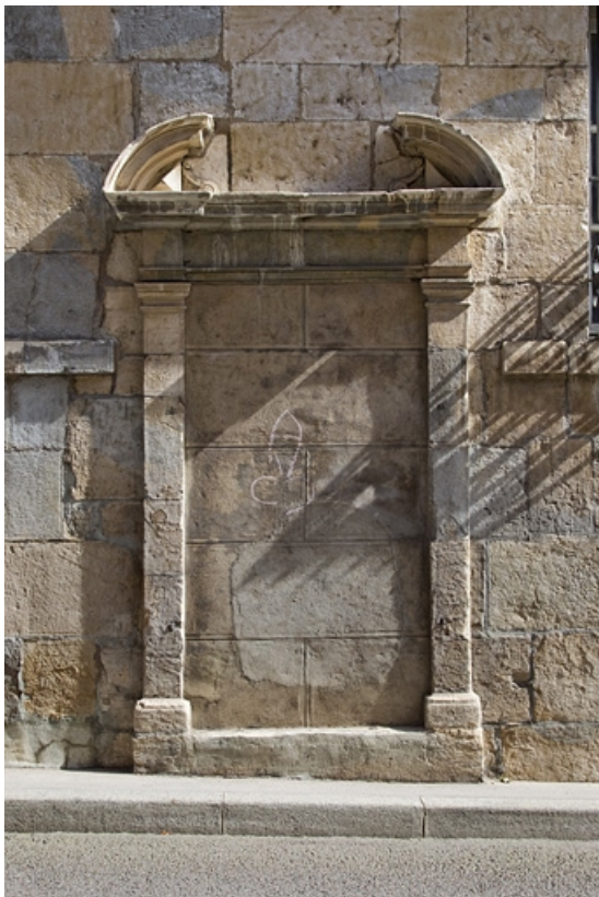
Premier logis secondaire, façade antérieure : détail d'une porte murée.
