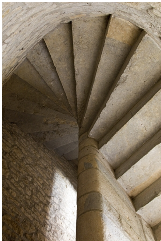
Premier logis secondaire : détail de l'escalier en vis.
