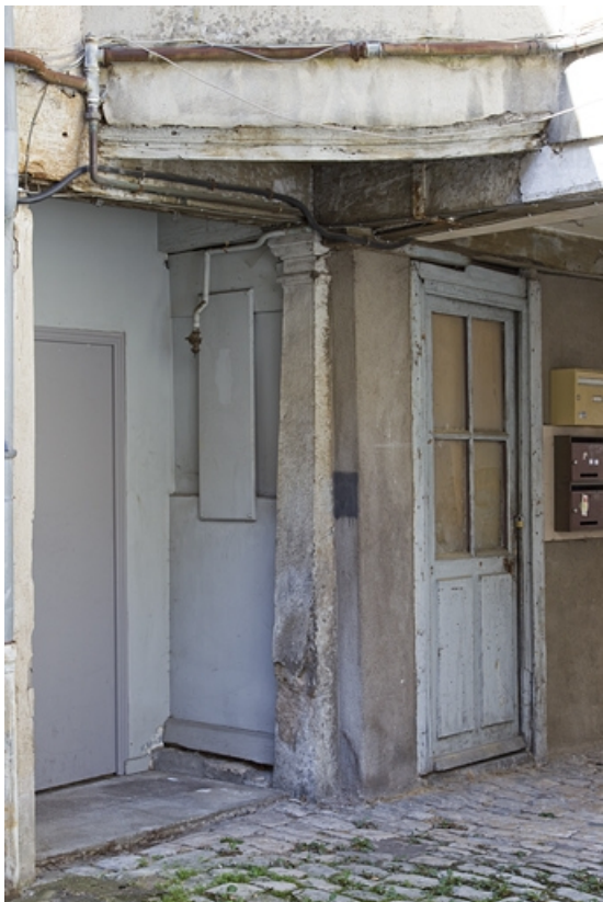
Façade postérieure du premier logis secondaire, vestiges supposés d'un portique : détail d'un pilier. 25, Besançon, 37 rue Renan, lieudit : îlot Cingle
