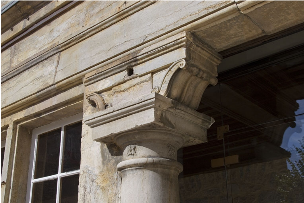
Logis principal, façade postérieure : détail d'une zapata du portique, de trois quarts droit. 25, Besançon, 6 rue du Palais, lieudit : îlot Cingle
