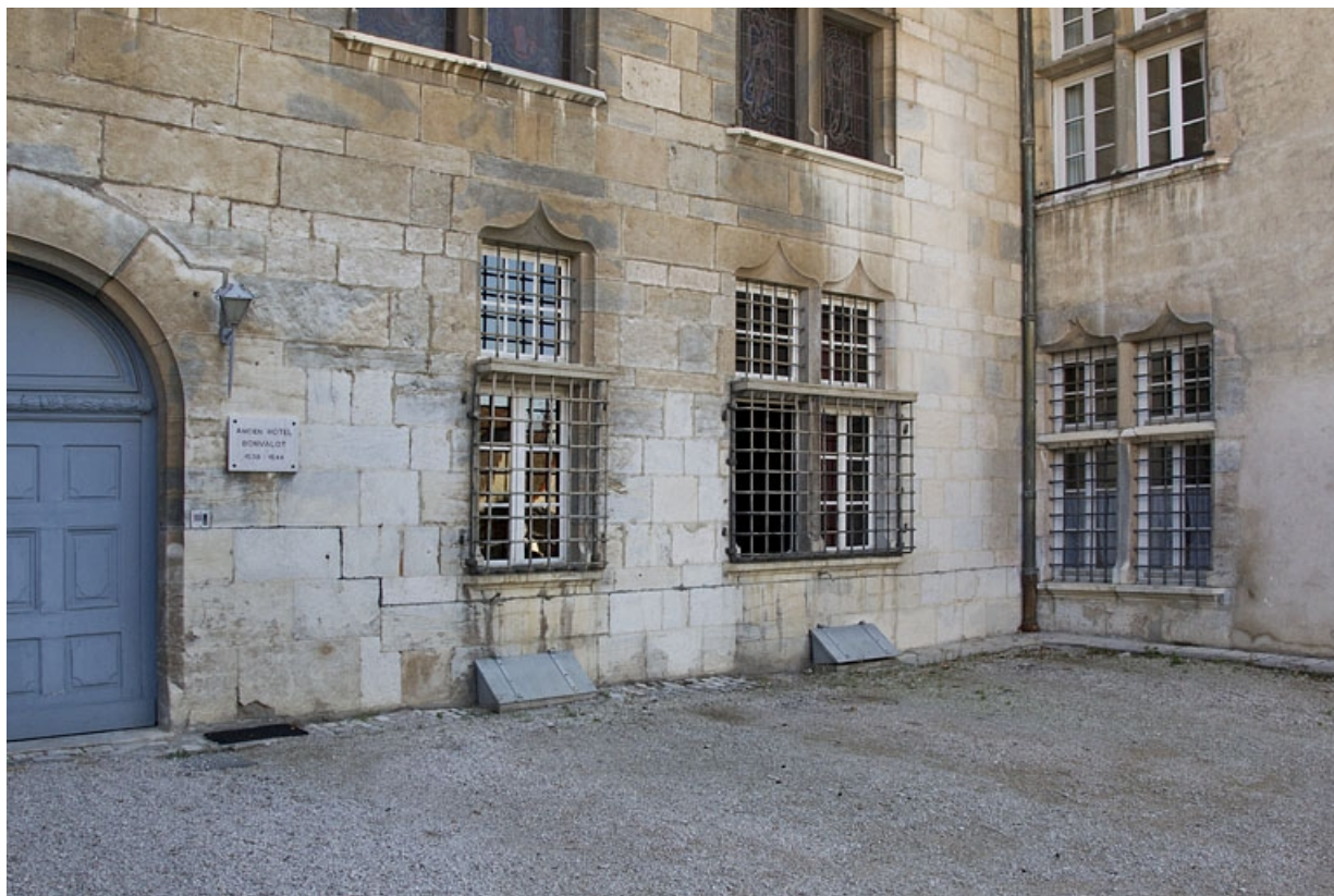
Logis principal, façade antérieure : détail du rez-de-chaussée de la partie droite.
