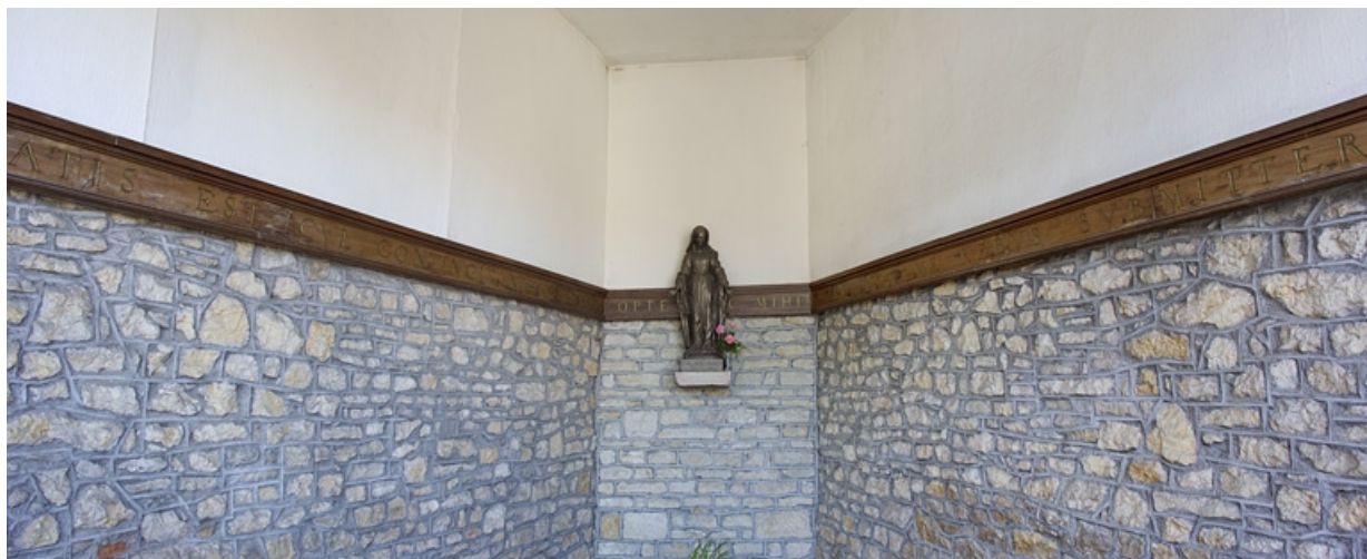
Fabrique de jardin : vue de l'intérieur, de face.
