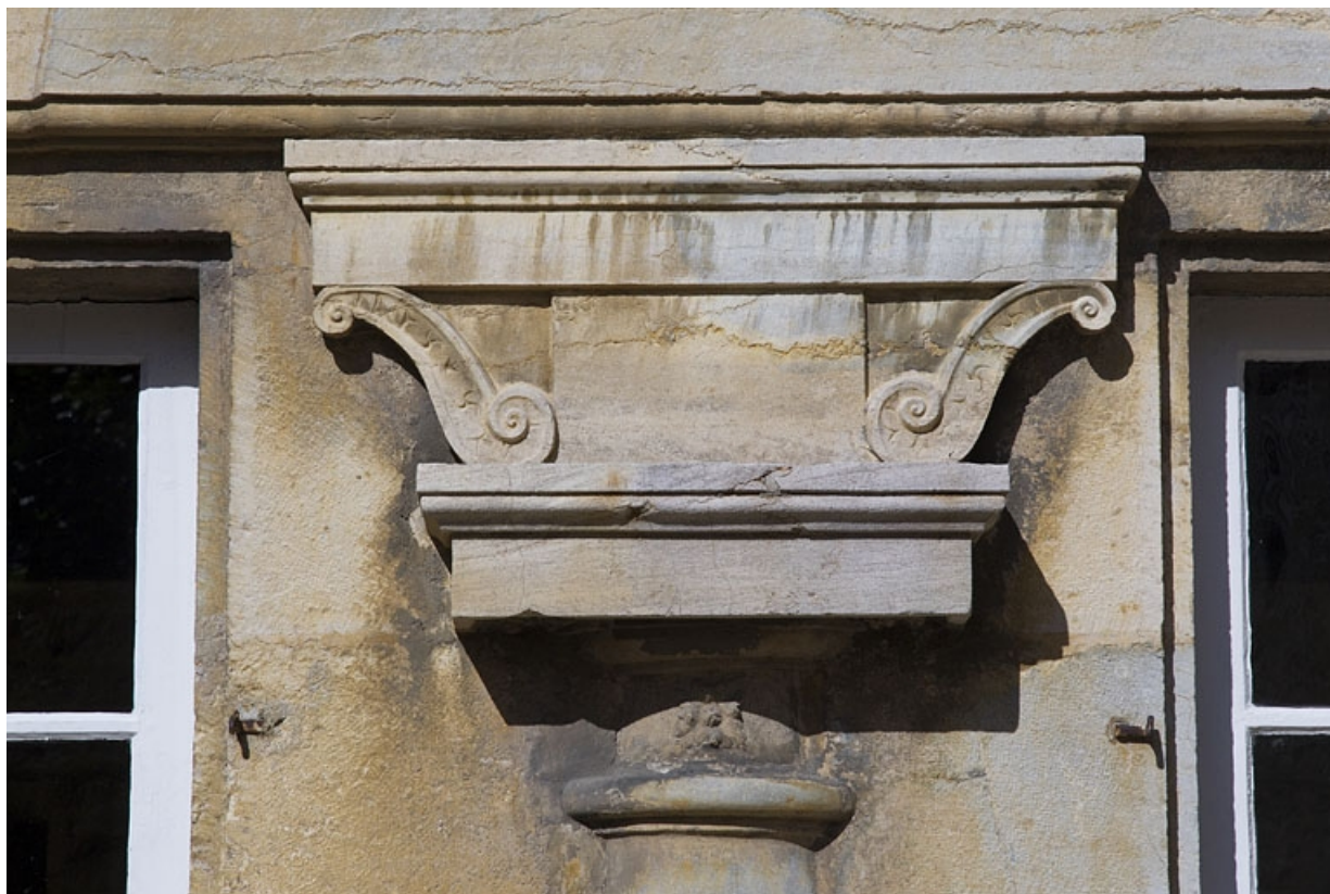
Logis principal, façade postérieure : détail d'une zapata du portique : de face. 25, Besançon, 6 rue du Palais, lieudit : îlot Cingle
