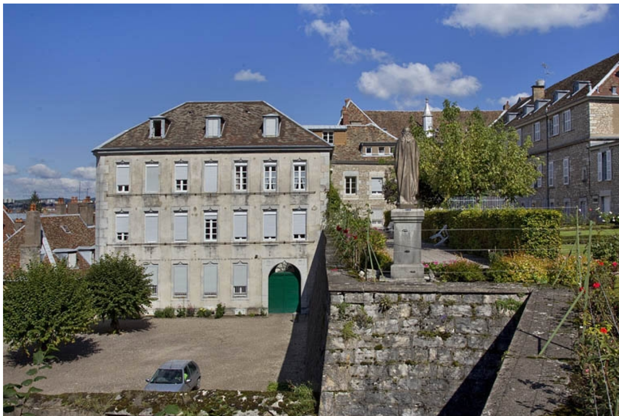
Vue d'ensemble de la basse-cour, depuis le fond du jardin.
