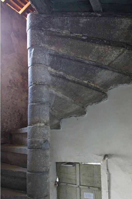
Deuxième logis secondaire : détail d'escalier en vis.
