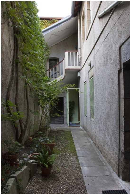
Deuxième logis secondaire : détail de la façade postérieure depuis l'entrée de la deuxième courette.
