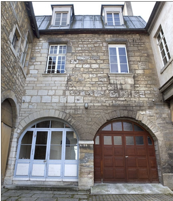
Vue d'ensemble de la façade antérieure du logis en fond de cour.
