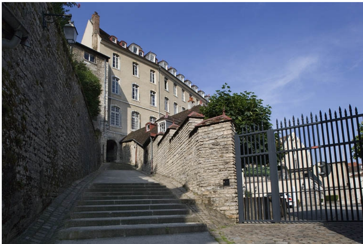
Vue de la façade postérieure depuis la rue du Chambrier. 25, Besançon, 11 rue de la Convention, lieudit : îlot Boitouset
