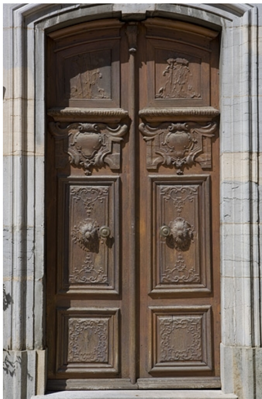
Détail des vantaux de la porte d'entrée du logis.
