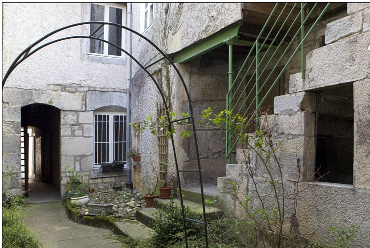
Deuxième cour : vue de l'escalier, de trois quarts droit.
