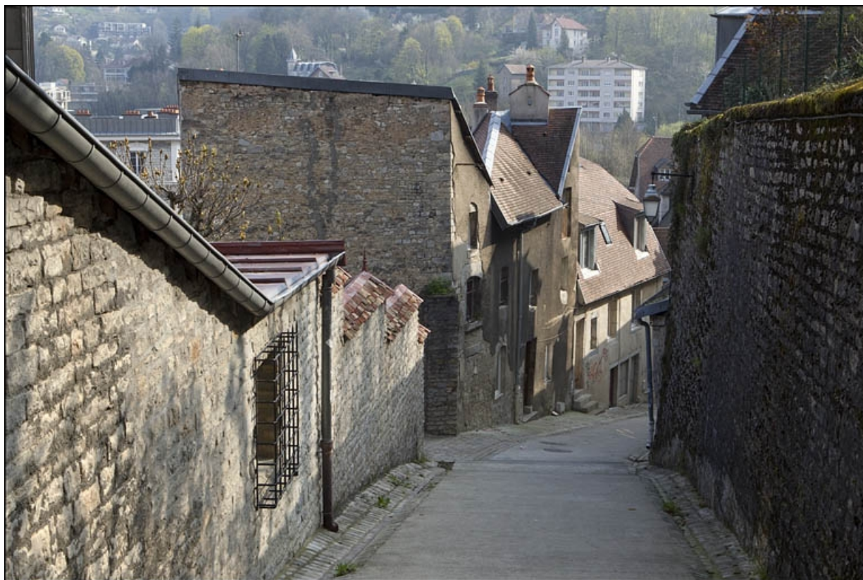
Façade latérale gauche du logis secondaire, en descendant la rue du Chambrier. 25, Besançon, 28 rue Rivotte, lieudit : îlot Boitouset
