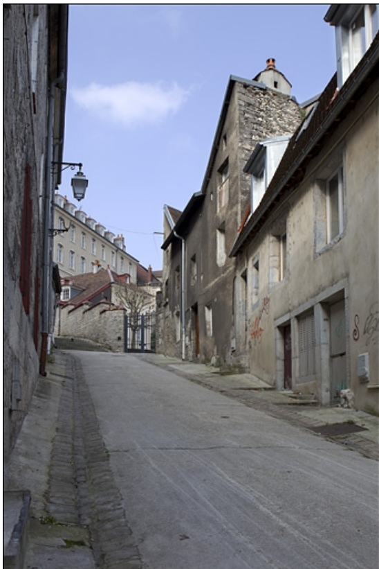
Façade latérale gauche du logis secondaire, en montant la rue du Chambrier. 25, Besançon, 28 rue Rivotte, lieudit : îlot Boitouset
