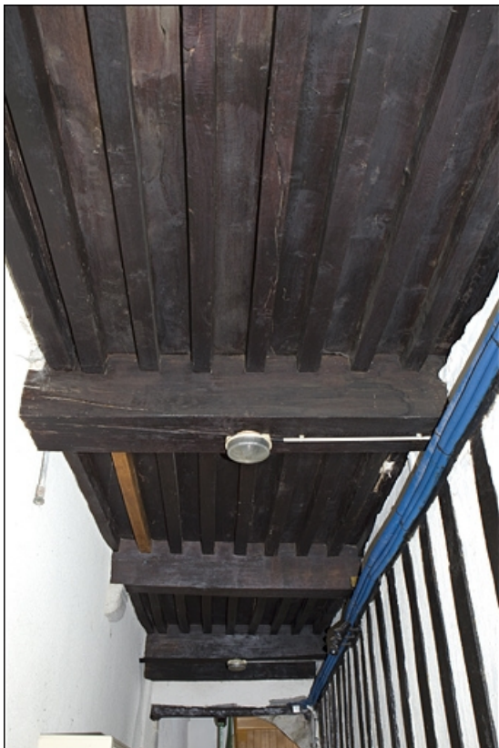
Vue du plafond à la française du passage cocher.
