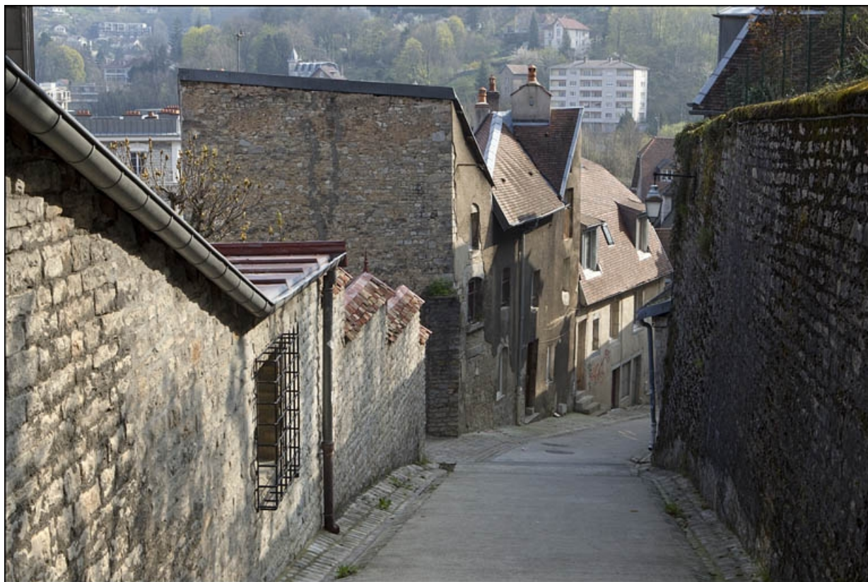
Façade latérale gauche du logis secondaire, en descendant la rue du Chambrier. 25, Besançon, 28 rue Rivotte, lieudit : îlot Boitouset
