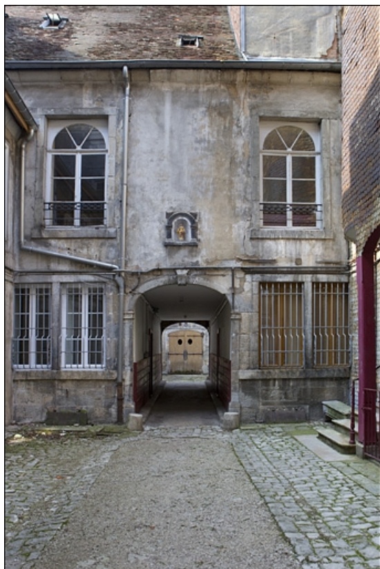
Façade antérieure du premier logis secondaire donnant sur la première cour. 25, Besançon, 22 rue Rivotte, lieudit : îlot Boitouset
