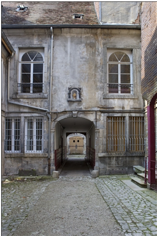
Façade antérieure du premier logis secondaire donnant sur la première cour. 25, Besançon, 22 rue Rivotte, lieudit : îlot Boitouset
