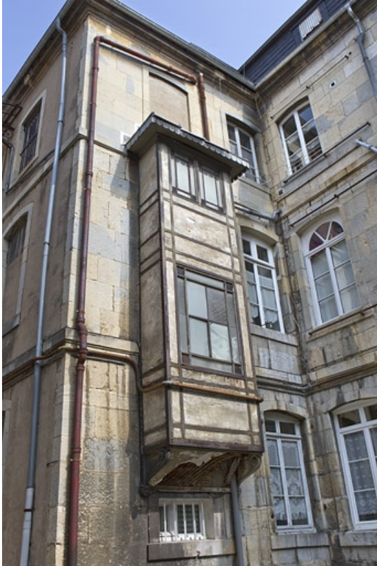
Détail d'une logette sur la façade postérieure du logis principal.
