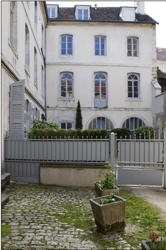
Vue de la façade antérieure de l'aile en fond de cour.
