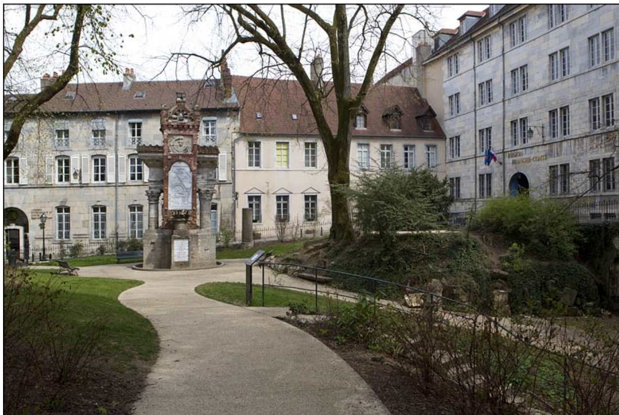
Vue d'ensemble de la façade antérieure du logis principal depuis le square Castan.
