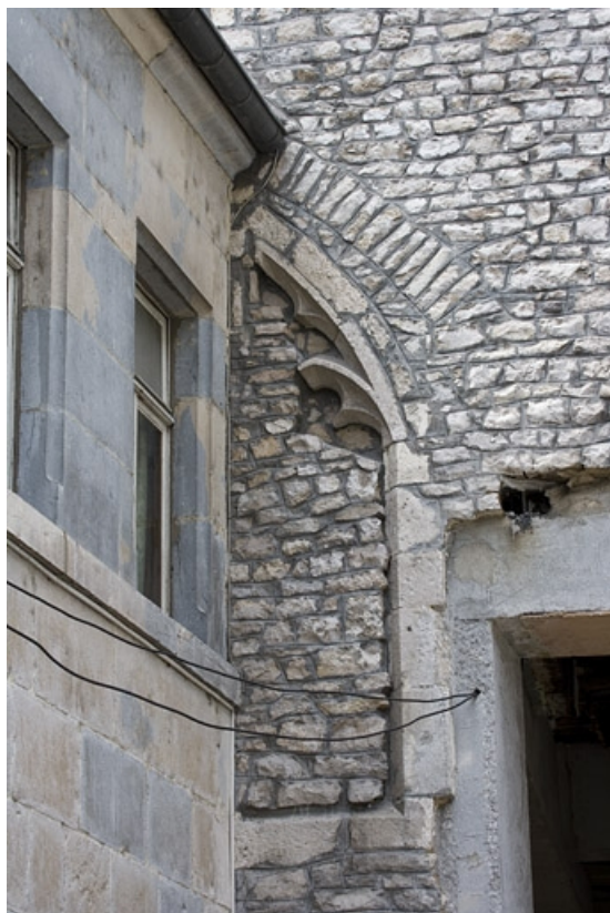
Partie gauche de l'édifice : détail du vestige de baie gothique.
