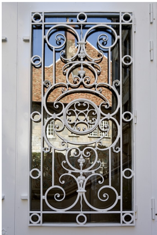
Détail de la ferronnerie de la porte d'entrée : bâtiment au fond de la cour.
