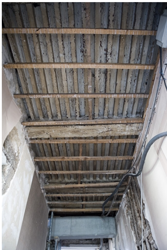
Vue du passage cocher avec plafond à la française.
