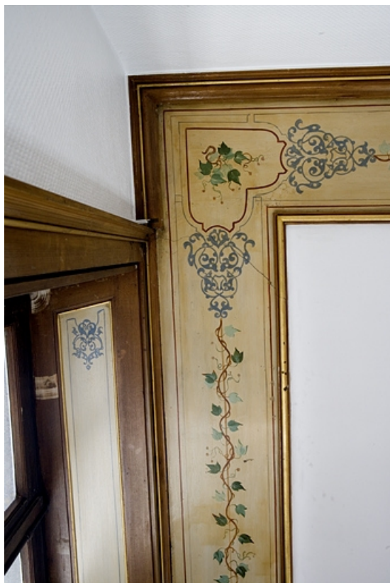
Intérieur, premier étage : détail du décor peint sur le plafond et l'encadrement de fenêtre d'une pièce.
