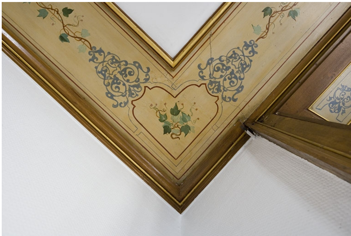
Intérieur, premier étage : détail du décor peint sur le plafond d'une pièce.
