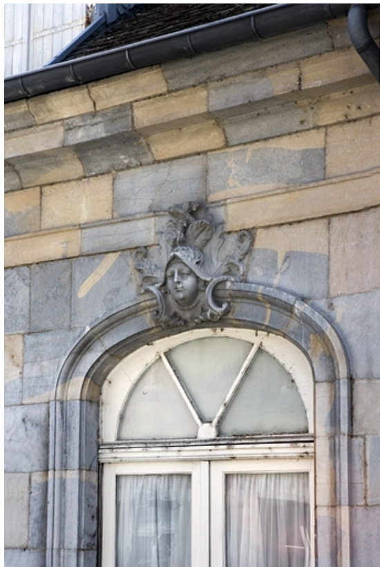
Détail de la sculpture sur l'arc de la porte-fenêtre : façade postérieure de la maison. 25, Besançon, 3, 5 rue de la Convention, lieudit : îlot Boitouset
