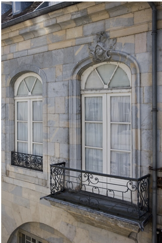
Détail de la porte-fenêtre sur la façade postérieure de la maison.
