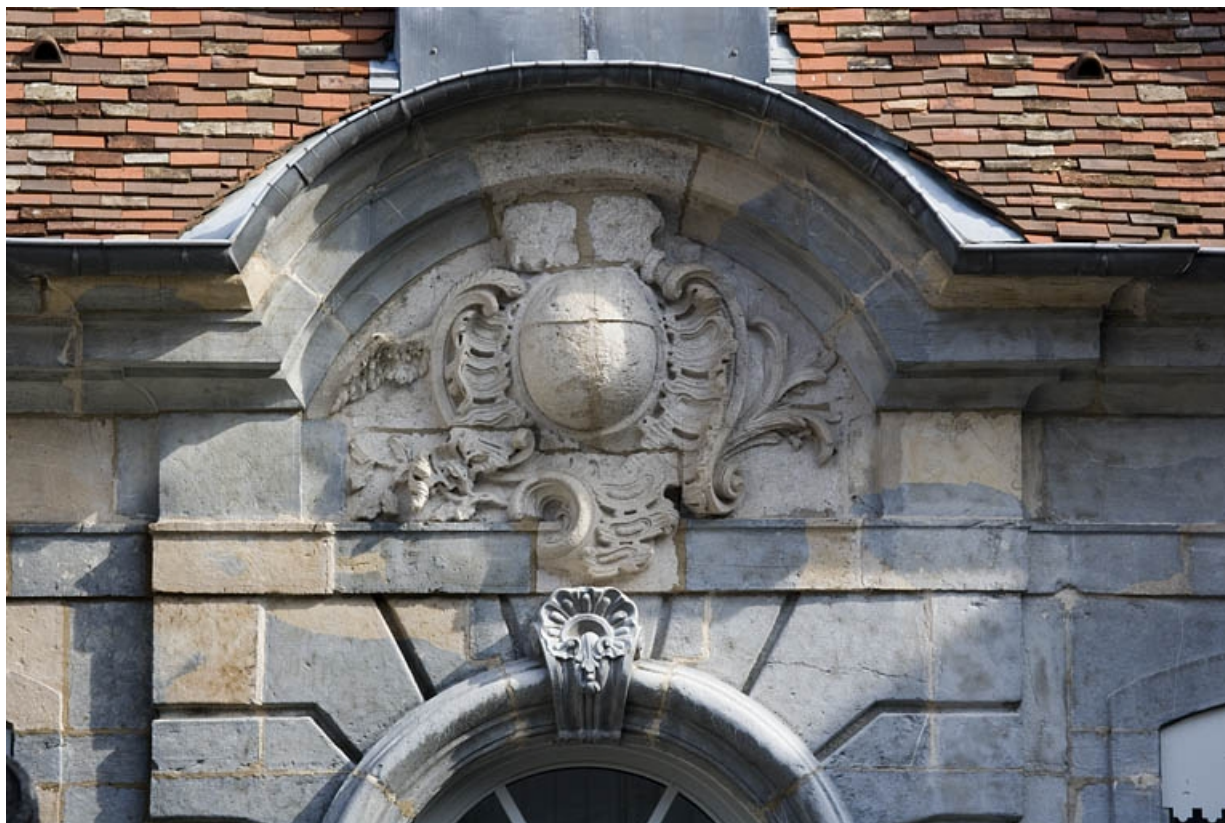
Détail de la sculpture à la partie supérieure de l'avant-corps central.
