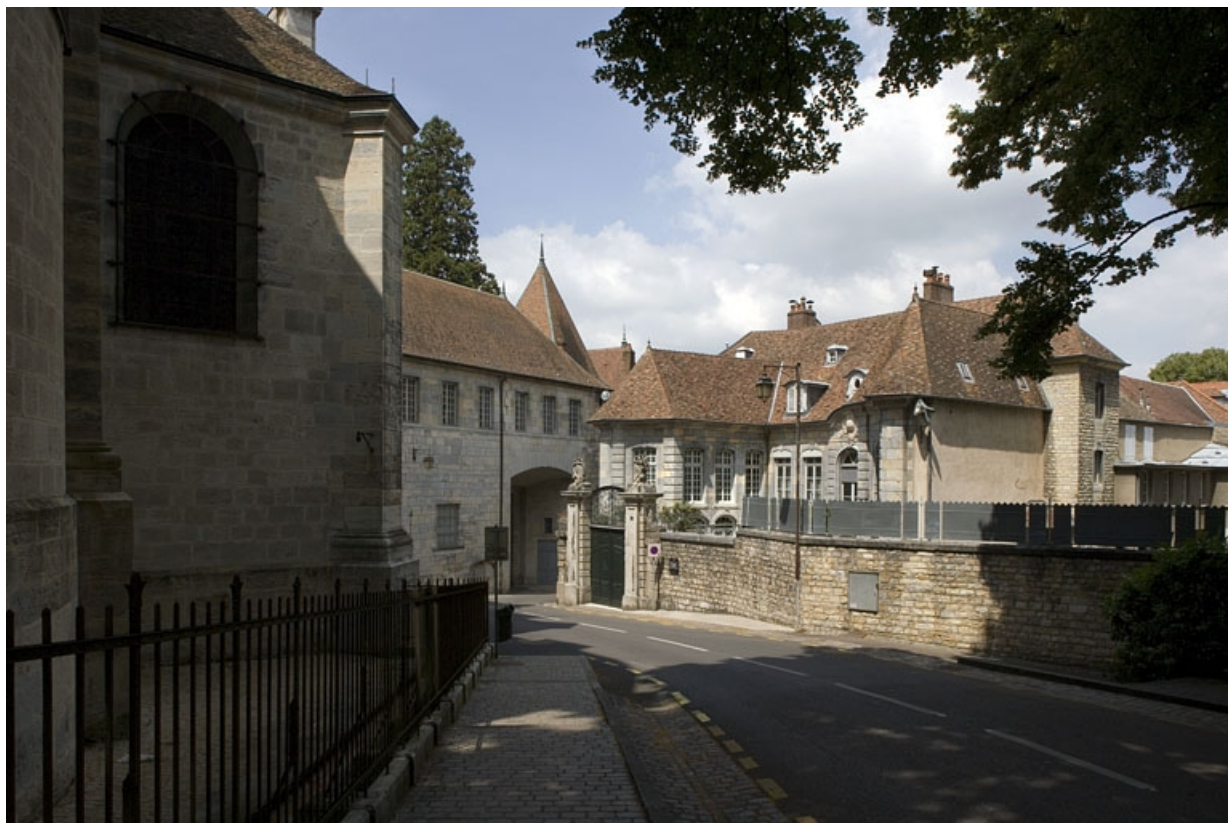
Vue d'ensemble de l'hôtel depuis la rue : vue éloignée de trois quarts droit.
