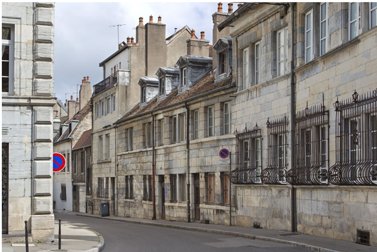
Vue d'ensemble du logis principal depuis la rue de trois quarts droit. 25, Besançon, 21 rue des Martelots, lieudit : îlot des Martelots
