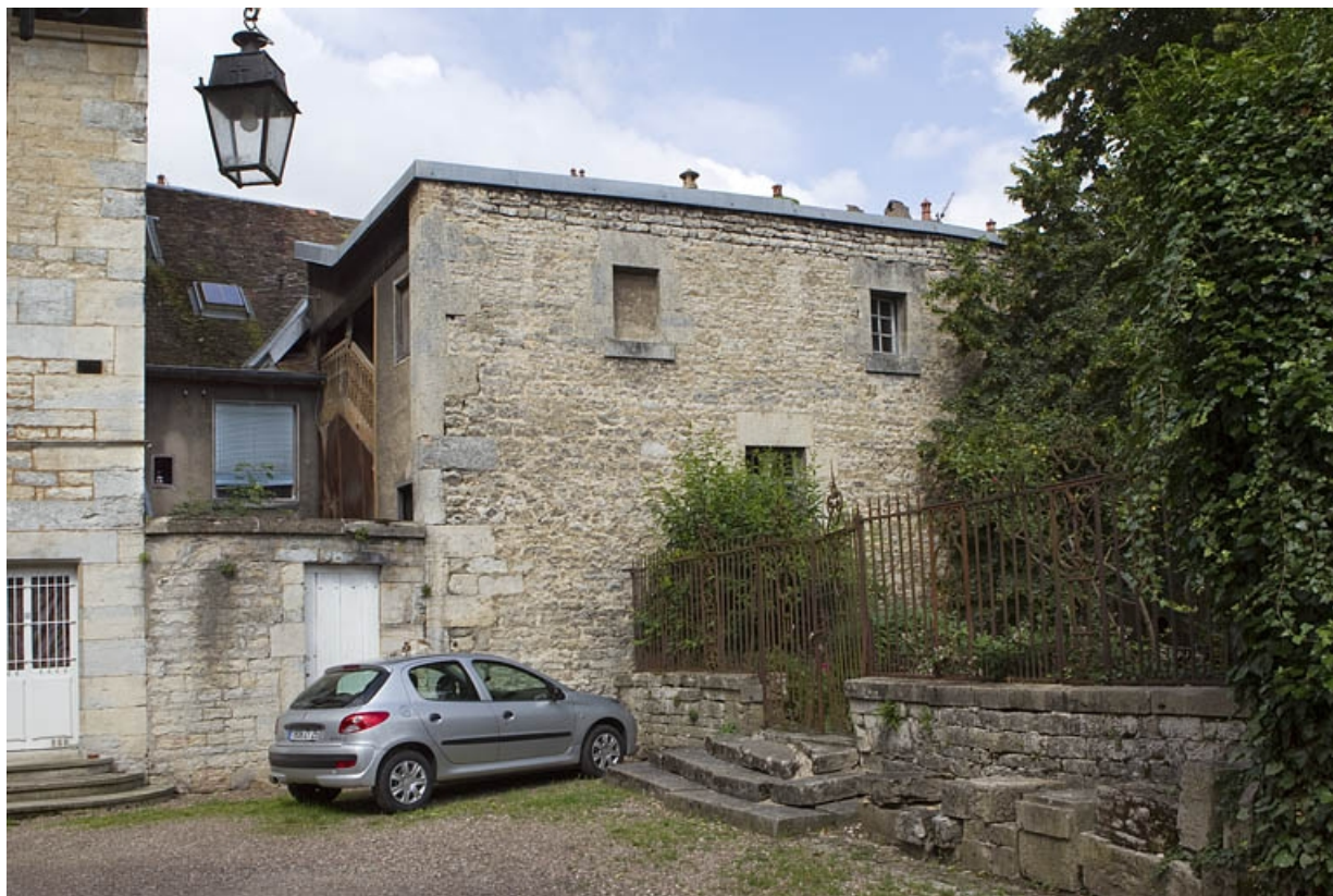
Vue d'ensemble de l'arrière de la maison depuis la cour de l'hôtel Alviset.
