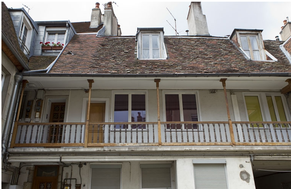
Vue d'ensemble de la galerie du logis principal depuis la cour.
