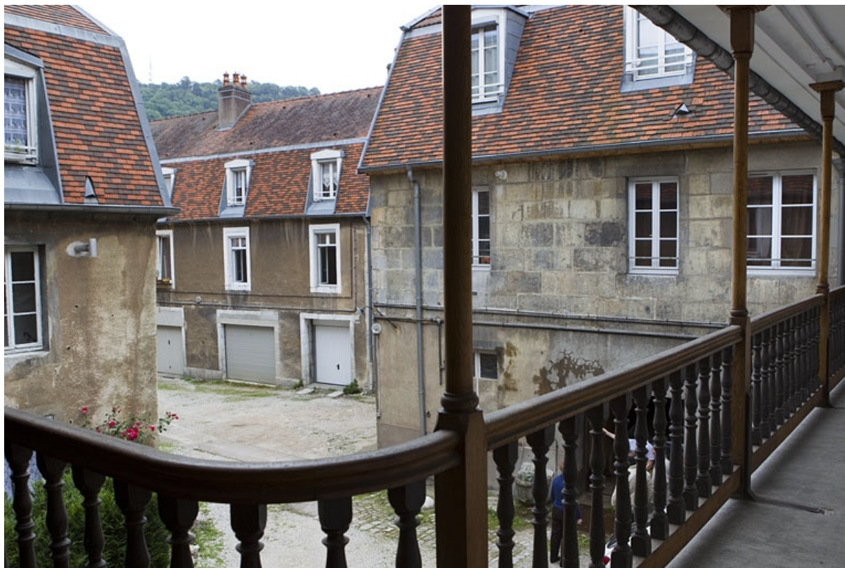
Vue d'ensemble des logis sur cour depuis la galerie du logis principal.
