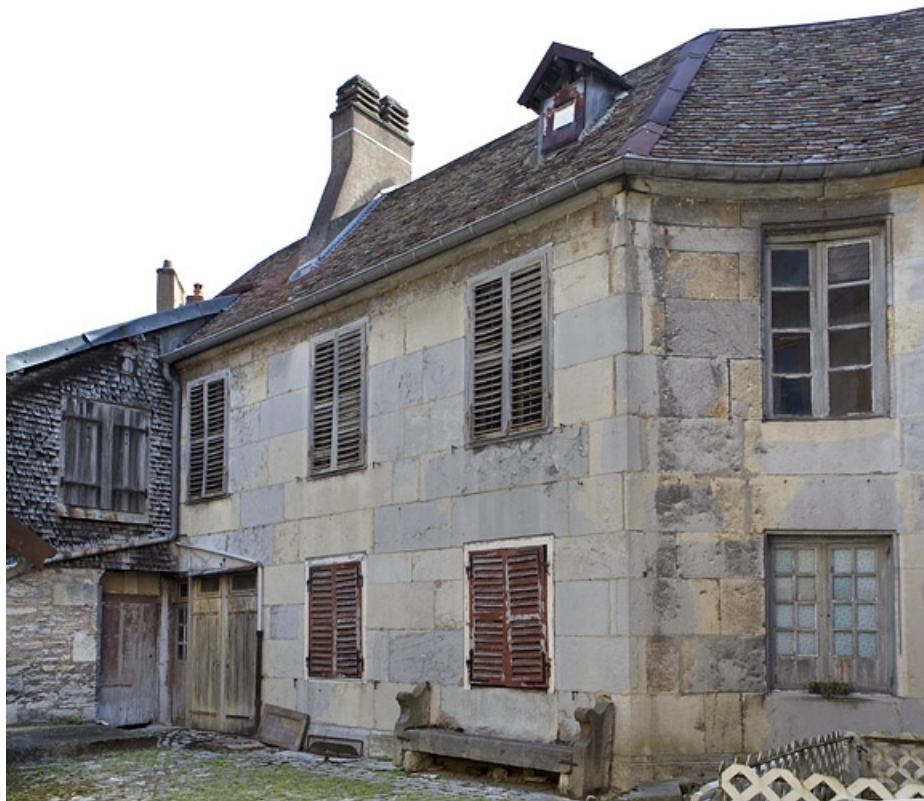
Vue d'ensemble de la façade antérieure du deuxième logis secondaire.
