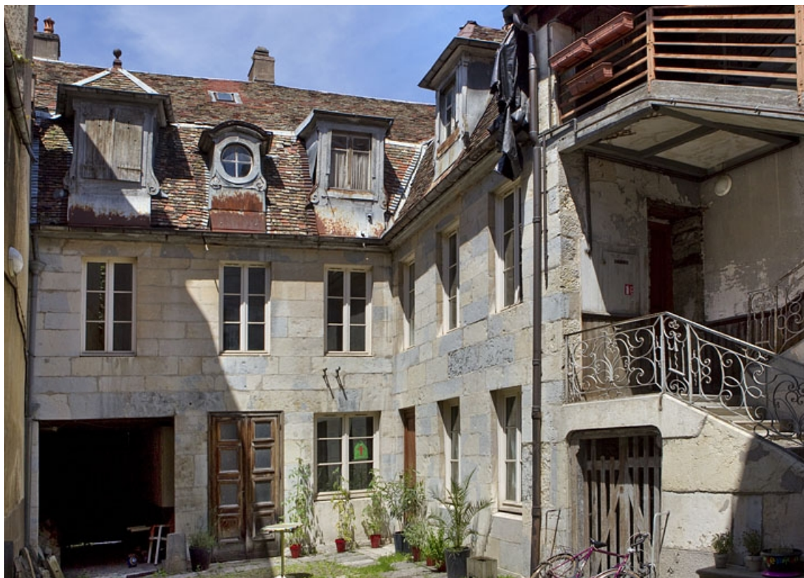
Vue d'ensemble du premier logis secondaire sur la première cour.
