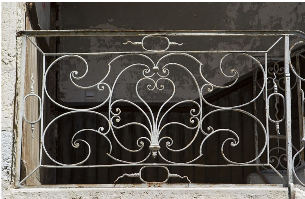
Détail d'un panneau en fer forgé de la rampe de l'escalier à cage ouverte.
