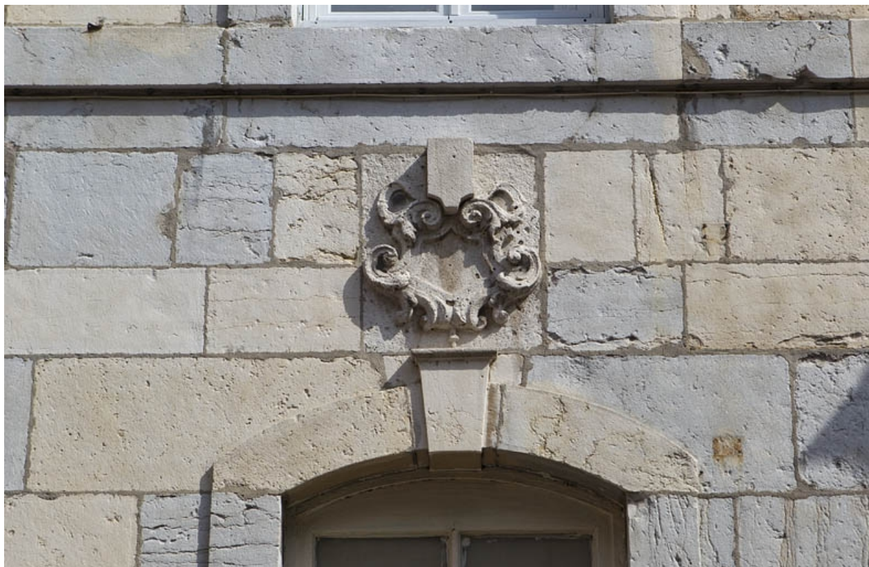
Détail du décor au-dessus d'une baie du rez-de-chaussée.
