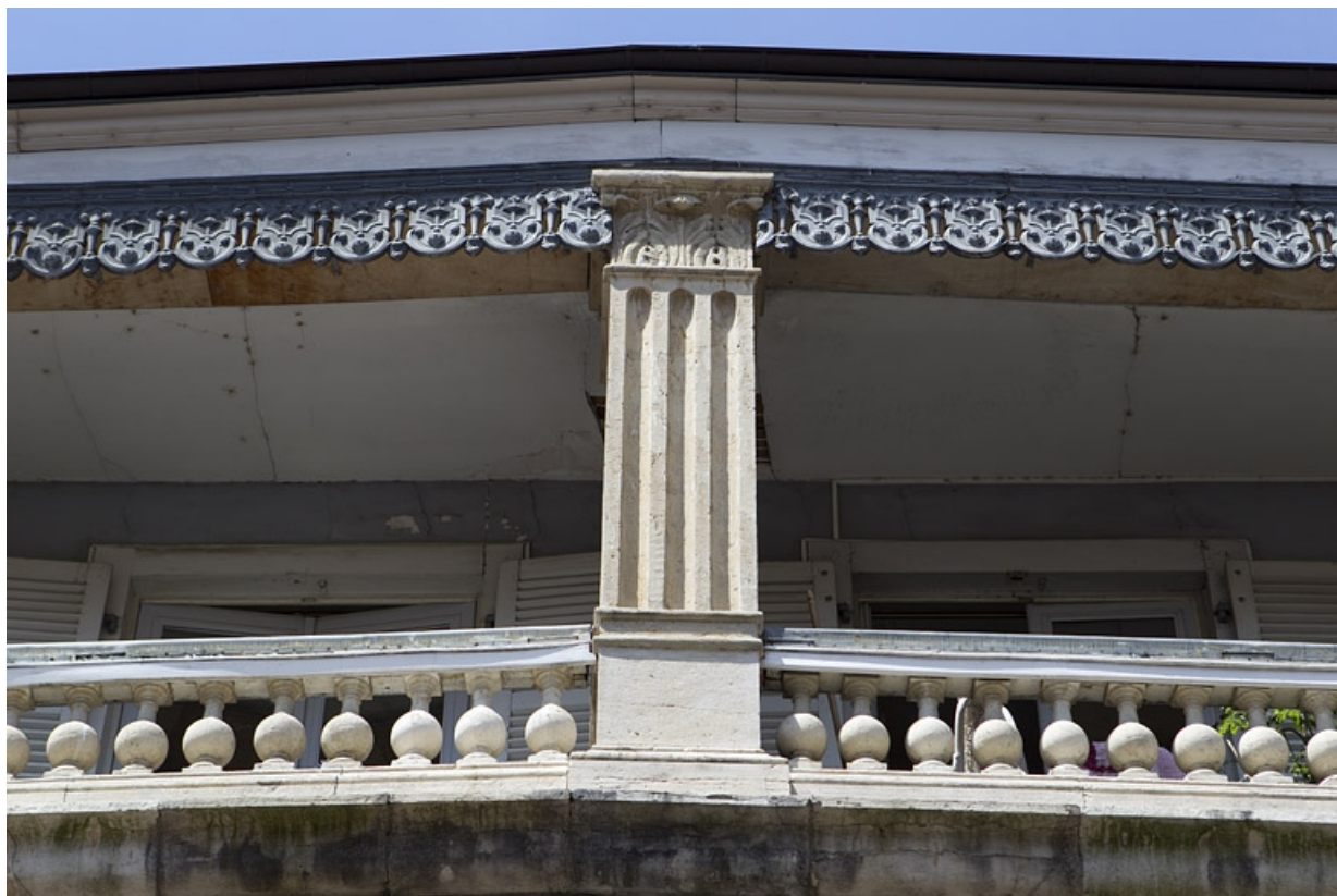
Façade sur rue du logis principal : détail de l'étage de surélévation, vue rapprochée, de face. 25, Besançon, 5 rue Péclet, lieudit : îlot des Martelots
