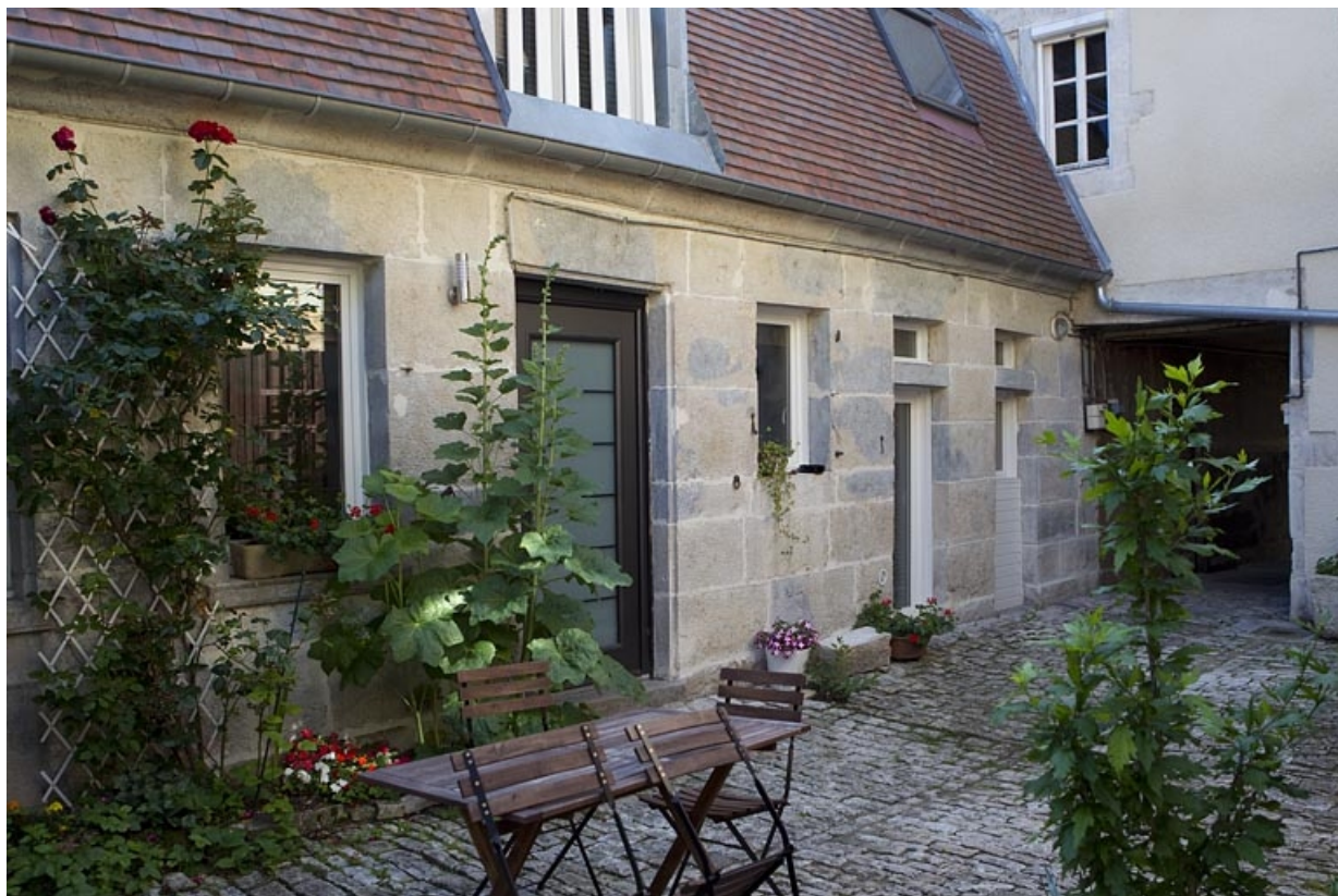
Vue d'ensemble du bâtiment des communs dans la deuxième cour.
