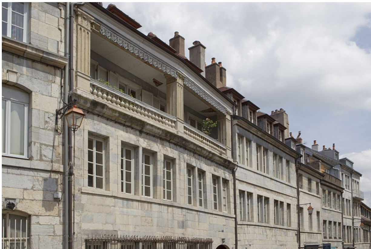
Façade sur rue du logis principal : détail de l'étage de surélévation, de trois quarts gauche. 25, Besançon, 5 rue Pécelet, lieudit : îlot des Martelots
