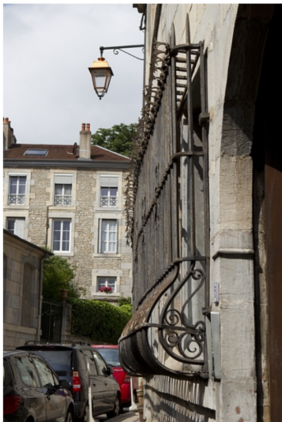
Façade sur rue du logis principal : détail des grilles devant les fenêtres du rez-de-chaussée, de profil. 25, Besançon, 5 rue Pécelet, lieudit : îlot des Martelots
