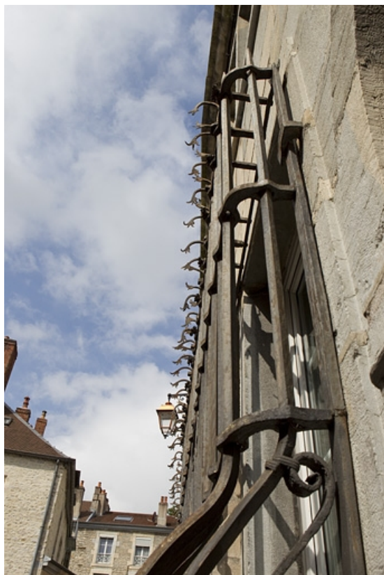
Façade sur rue du logis principal : détail des grilles devant les fenêtres du rez-de-chaussée, de profil, vue rapprochée. 25, Besançon, 5 rue Pécelet, lieudit : îlot des Martelots
