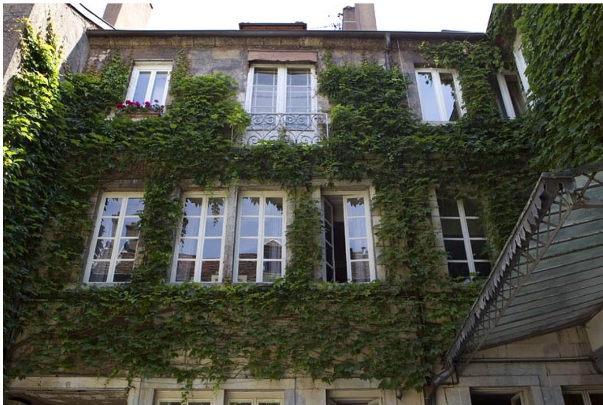
Façade postérieure du logis principal : détail de la partie supérieure.
