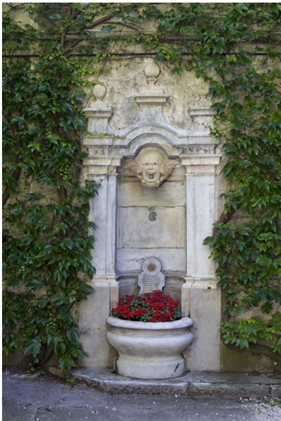
Détail de la borne fontaine dans la première cour. 25, Besançon, 5 rue Pécelet, lieudit : îlot des Martelots
