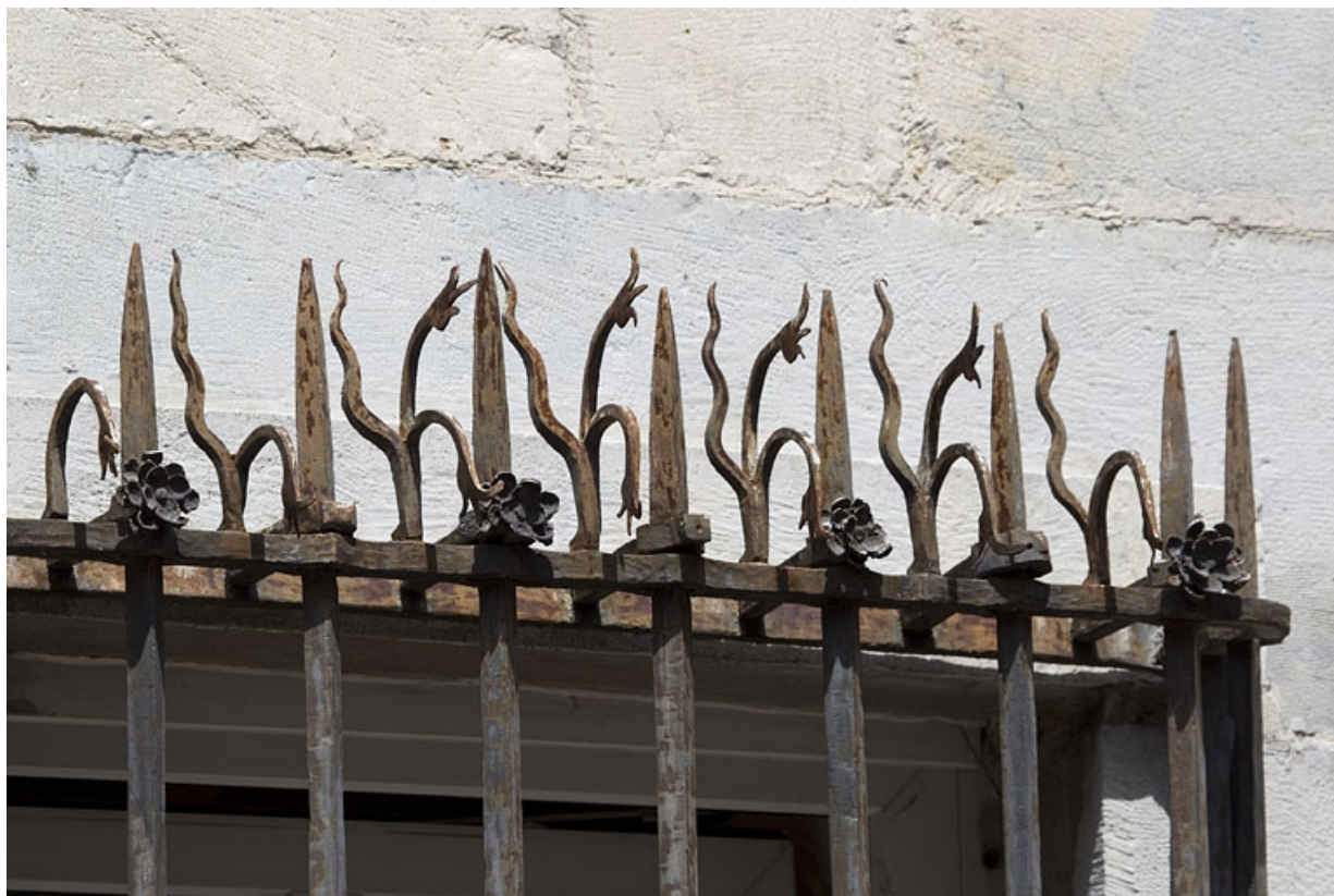
Façade sur rue du logis principal : détail de la partie supérieure des grilles devant les fenêtres du rez-de-chaussée. 25, Besançon, 5 rue Pécelet, lieudit : îlot des Martelots
