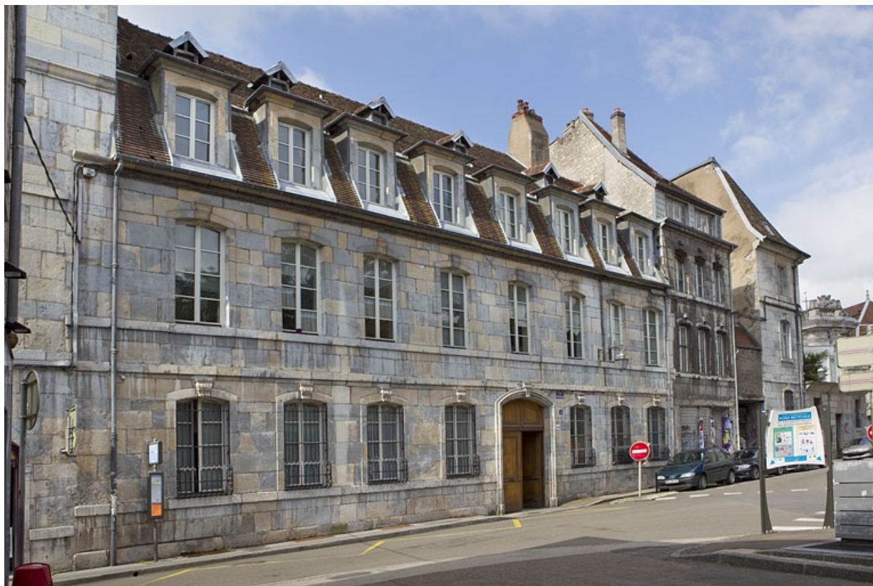
Vue d'ensemble de la façade sur rue du logis principal : des trois quarts gauche.
