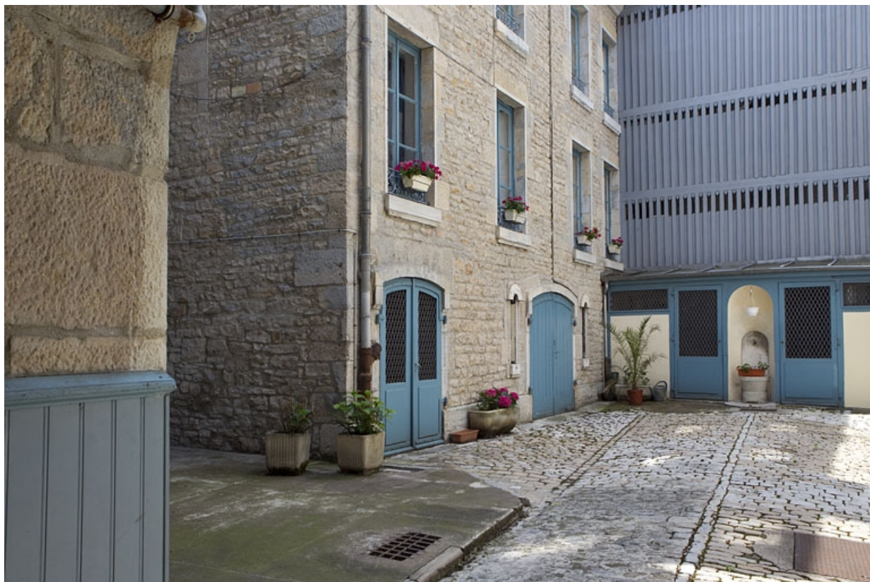
Détail du rez-de-chaussée du logis secondaire gauche. 25, Besançon, 6 rue de Pontarlier, lieudit : îlot des Martelots
