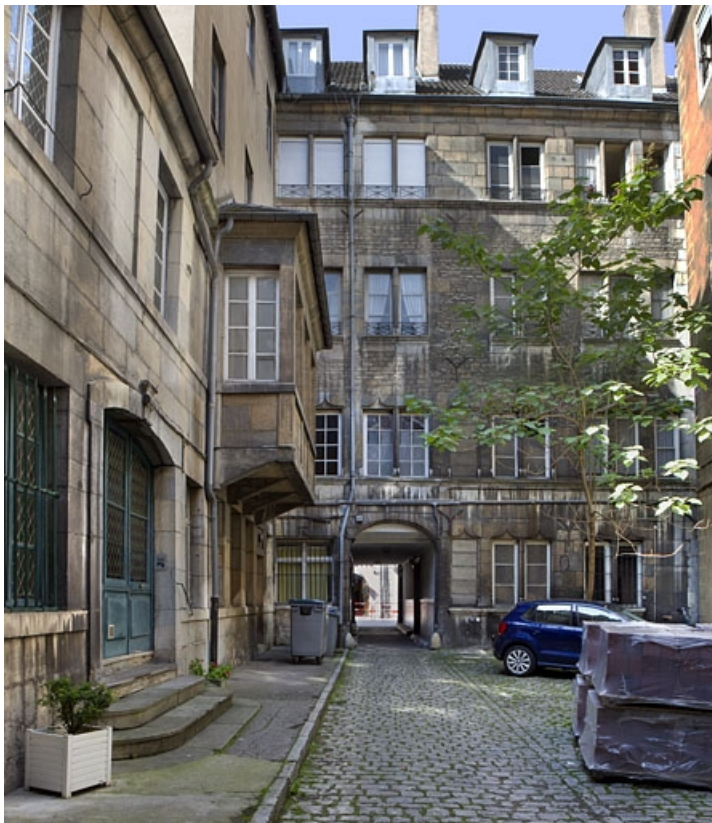
Façade postérieure sur cour de l'immeuble : vue d'ensemble de face. 25, Besançon, 123 Grande Rue, lieudit : îlot Saint-Maurice
