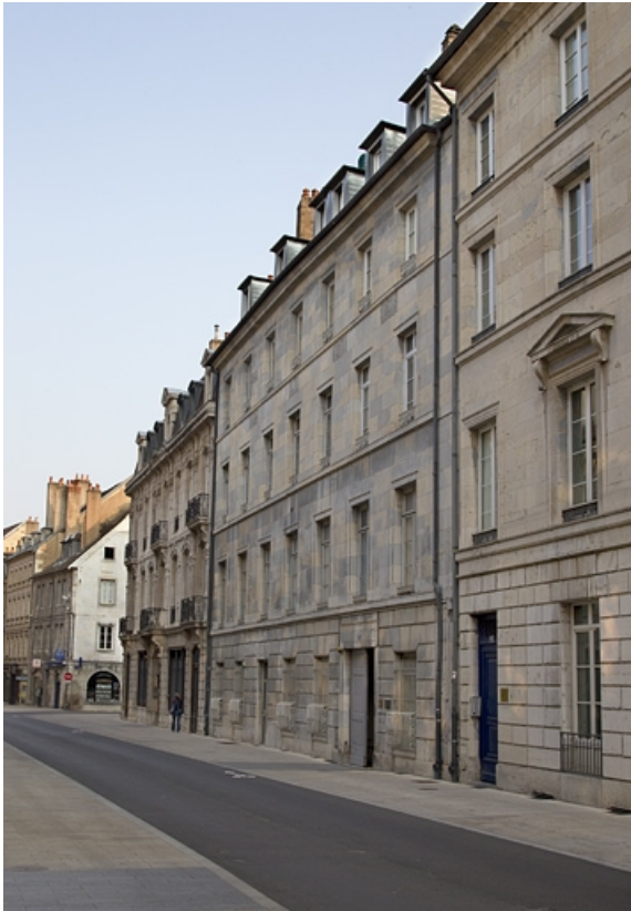
Vue d'ensemble de la façade antérieure de l'immeuble depuis la rue, de trois quarts droit. 25, Besançon, 123 Grande Rue, lieudit : îlot Saint-Maurice
