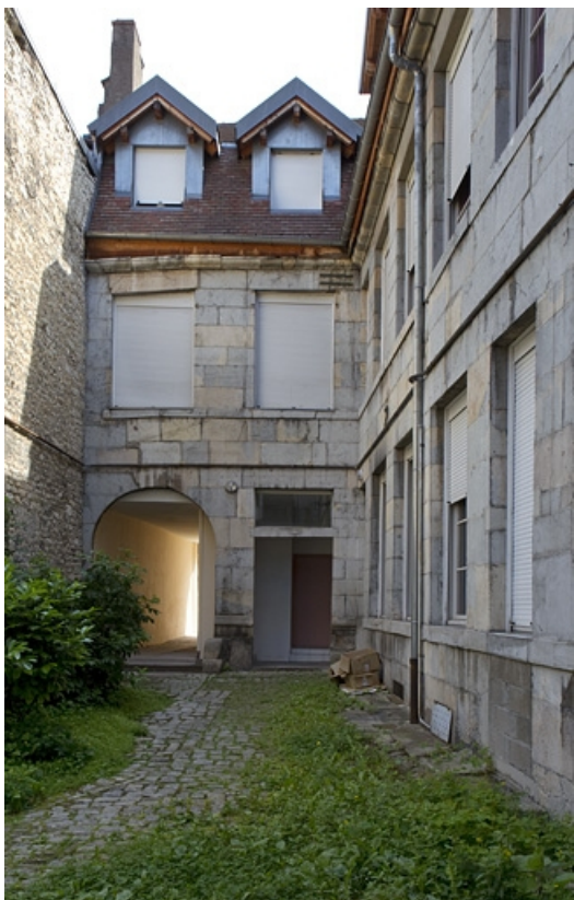
Logis secondaire en L : détail de l'aile en fond de cour. 25, Besançon, 133 Grande Rue, lieudit : îlot Saint-Maurice
