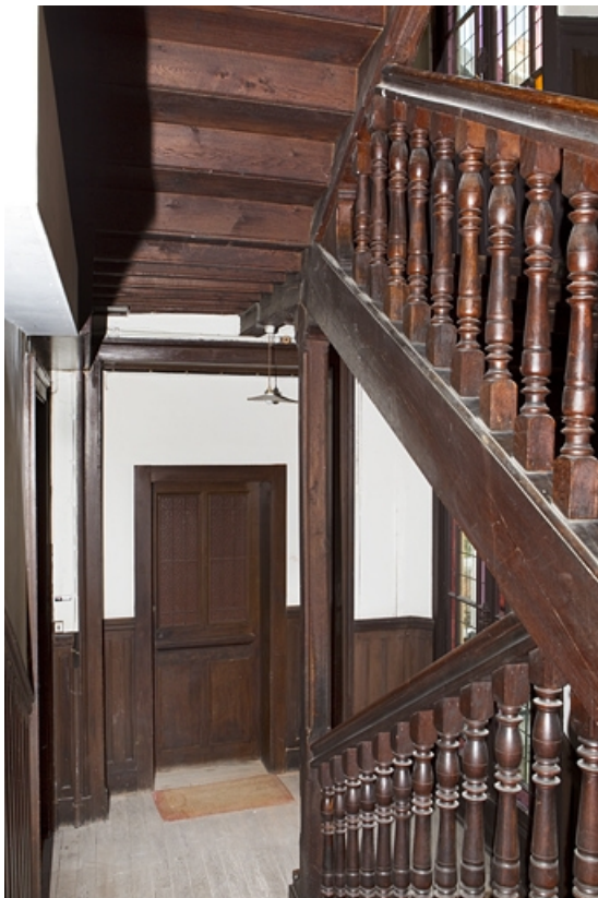
Cage d'escalier en pan de bois : détail de l'escalier.
