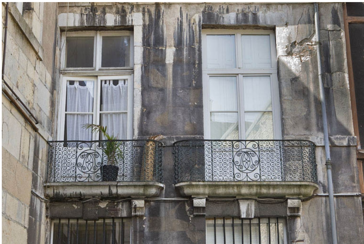
Logis principal, façade sur cour : détail des deux garde-corps.
