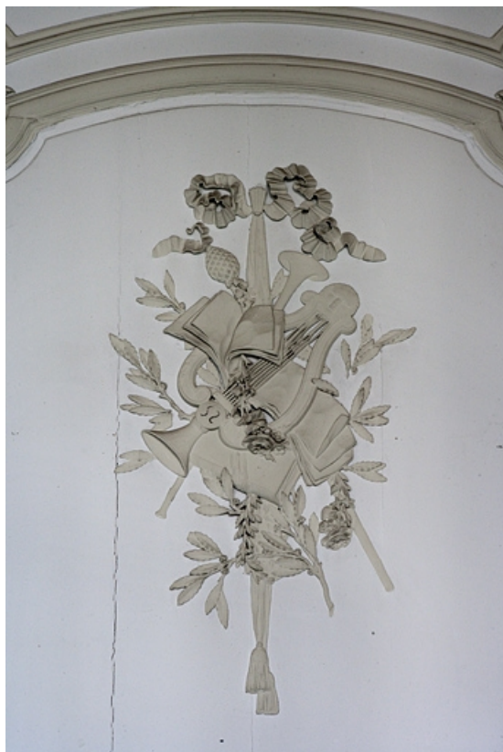
Intérieur, premier étage, pièce donnant sur la cour : détail d'un décor de lambris avec une lyre. 25, Besançon, 127 Grande Rue, lieudit : îlot Saint-Maurice
