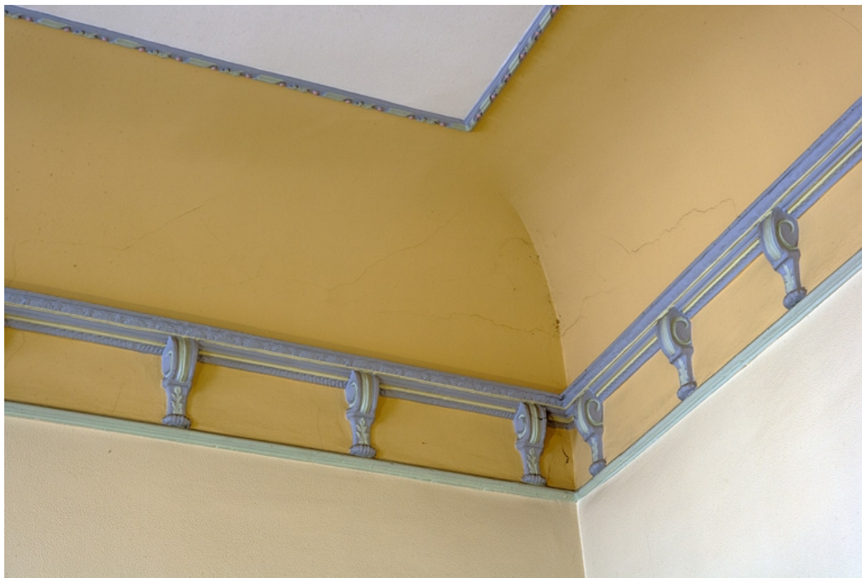
Intérieur, escalier : détail du plafond à voussures de la cage d'escalier.
