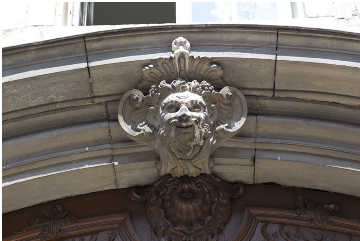
Façade antérieure sur rue, détail de la clé sur l'arc du portail d'entrée.
