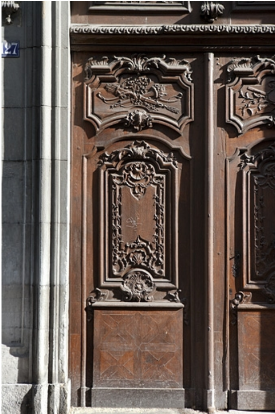
Façade antérieure sur rue, portail d'entrée : détail d'un vantaux de la porte.
