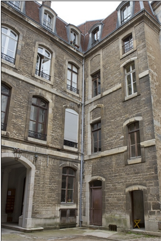
Façade postérieure sur cour : détail de l'aile gauche.
