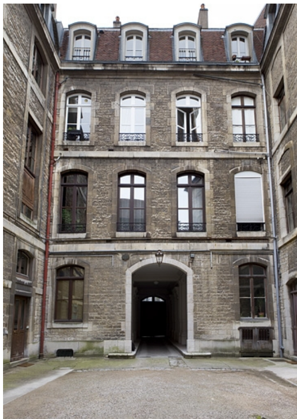
Façade postérieure sur cour : vue d'ensemble de face. 25, Besançon, 121 Grande Rue, lieudit : îlot Saint-Maurice
