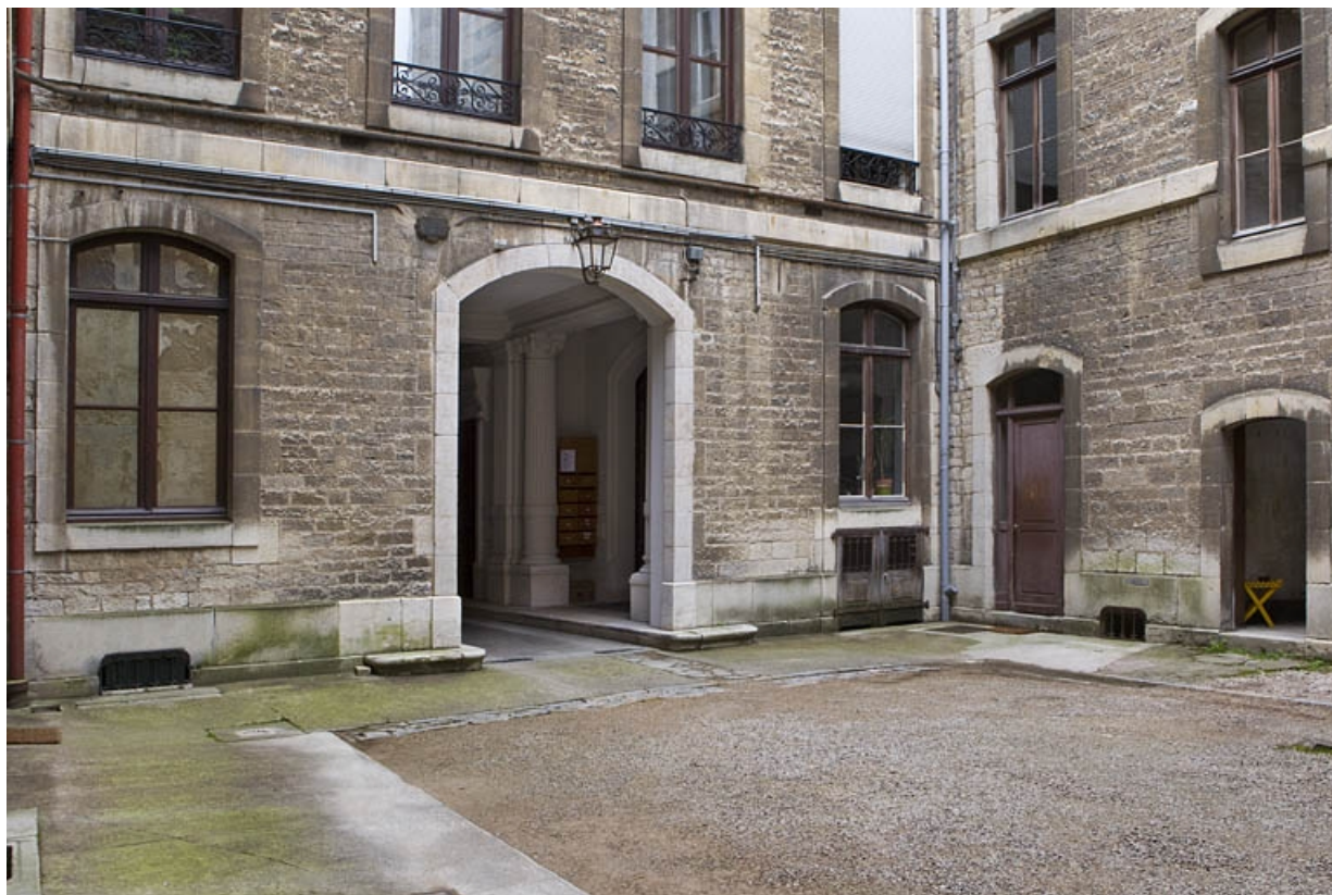
Façade postérieure sur cour : détail du rez-de-chaussée de trois quarts gauche. 25, Besançon, 121 Grande Rue, lieudit : îlot Saint-Maurice
