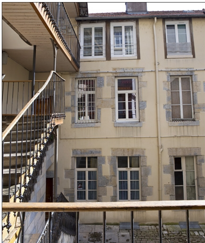
Vue d'ensemble de la façade antérieure du logis secondaire à droite de la première cour. 25, Besançon, 3 place Victor Hugo, lieudit : îlot Saint-Maurice
