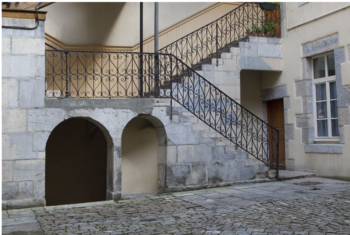
Escalier à cage ouverte sur cour : détail des deux premières volées.
