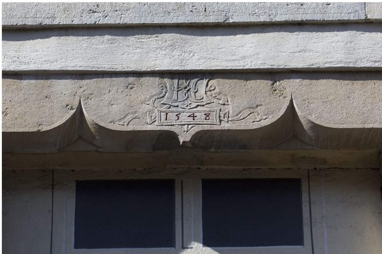
Façade latérale droite, baie en accolade de l'étage : détail de la date et du monogramme. 25, Besançon, 15 rue Victor Hugo, lieudit : îlot Saint-Maurice
