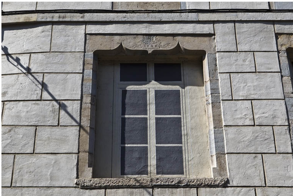
Façade latérale droite, détail d'une baie en accolade de l'étage.
