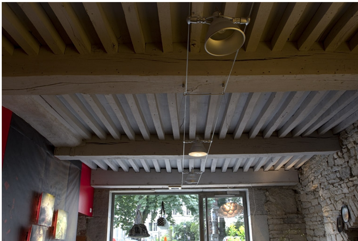
Intérieur : détail du plafond à la française d'une pièce du rez-de-chaussée.
