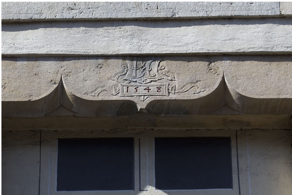
Façade latérale droite, baie en accolade de l'étage : détail de la date et du monogramme. 25, Besançon, 15 rue Victor Hugo, lieudit : îlot Saint-Maurice
