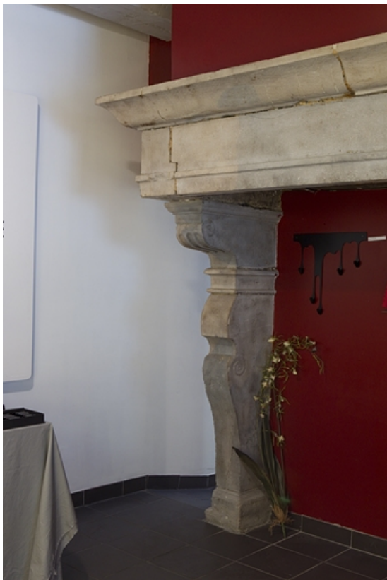
Intérieur, pièce du rez-de-chaussée : détail de la partie gauche de la cheminée. 25, Besançon, 15 rue Victor Hugo, lieudit : îlot Saint-Maurice
