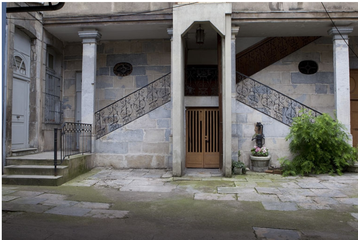
Vue du départ de l'escalier en fond de cour, de face.
