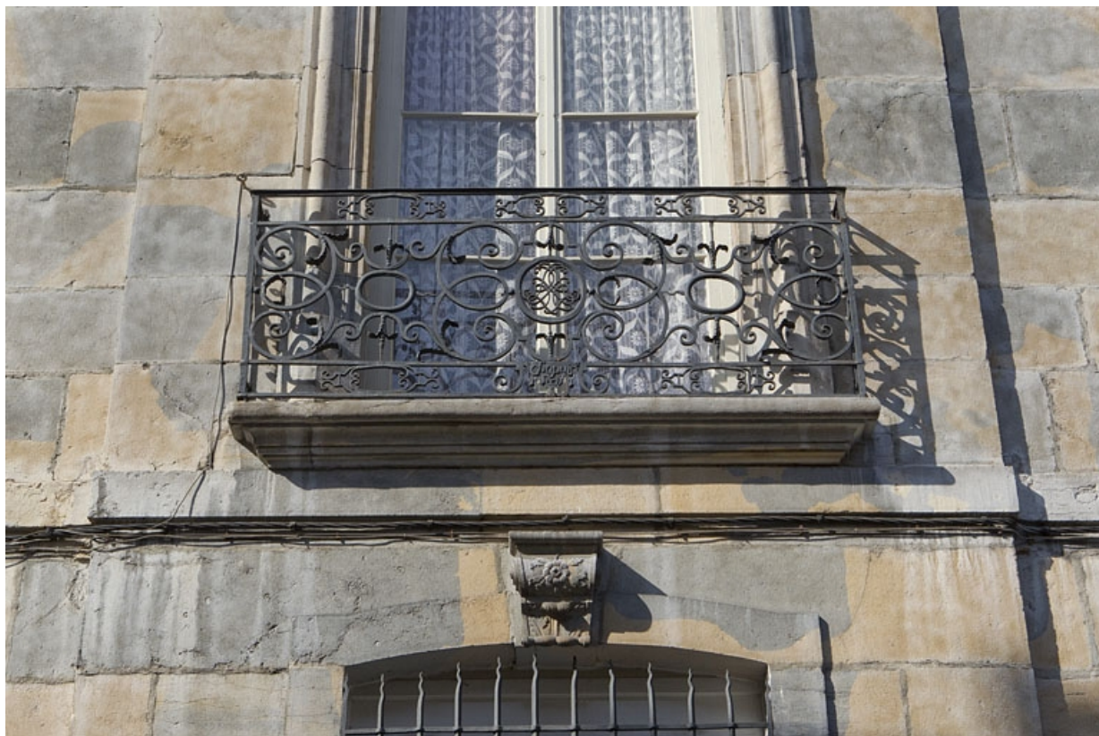
Aile droite : détail d'un garde-corps d'une fenêtre du premier étage.
