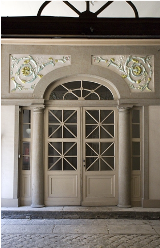
Passage cocher : détail de la porte d'entrée de l'escalier, de face.
