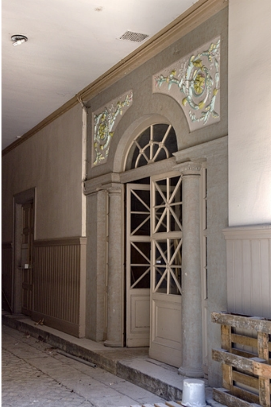
Passage cocher : détail de la porte d'entrée de l'escalier. 25, Besançon, 2 rue des Martelots, lieudit : îlot Saint-Maurice
