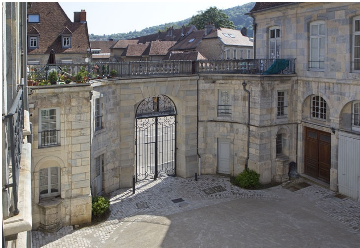
Vue d'ensemble de la clôture sur rue depuis la cour, de trois quarts gauche. 25, Besançon, 2 place Jean Cornet, lieudit : îlot Saint-Maurice
