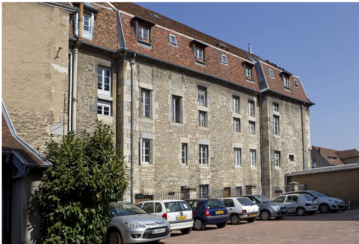
Vue d'ensemble de la façade postérieure de l'aile gauche sur cour.
