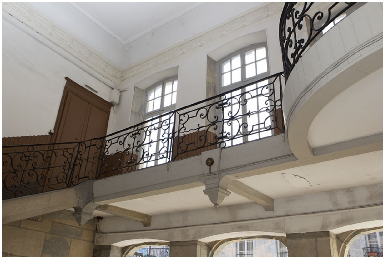
Aile droite, escalier : premier étage, vue de la grille en ferronnerie du palier.
