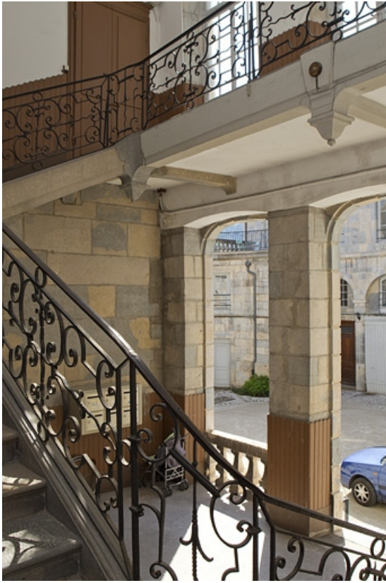
Aile droite : vue d'ensemble de l'escalier avec vue sur la cour.
