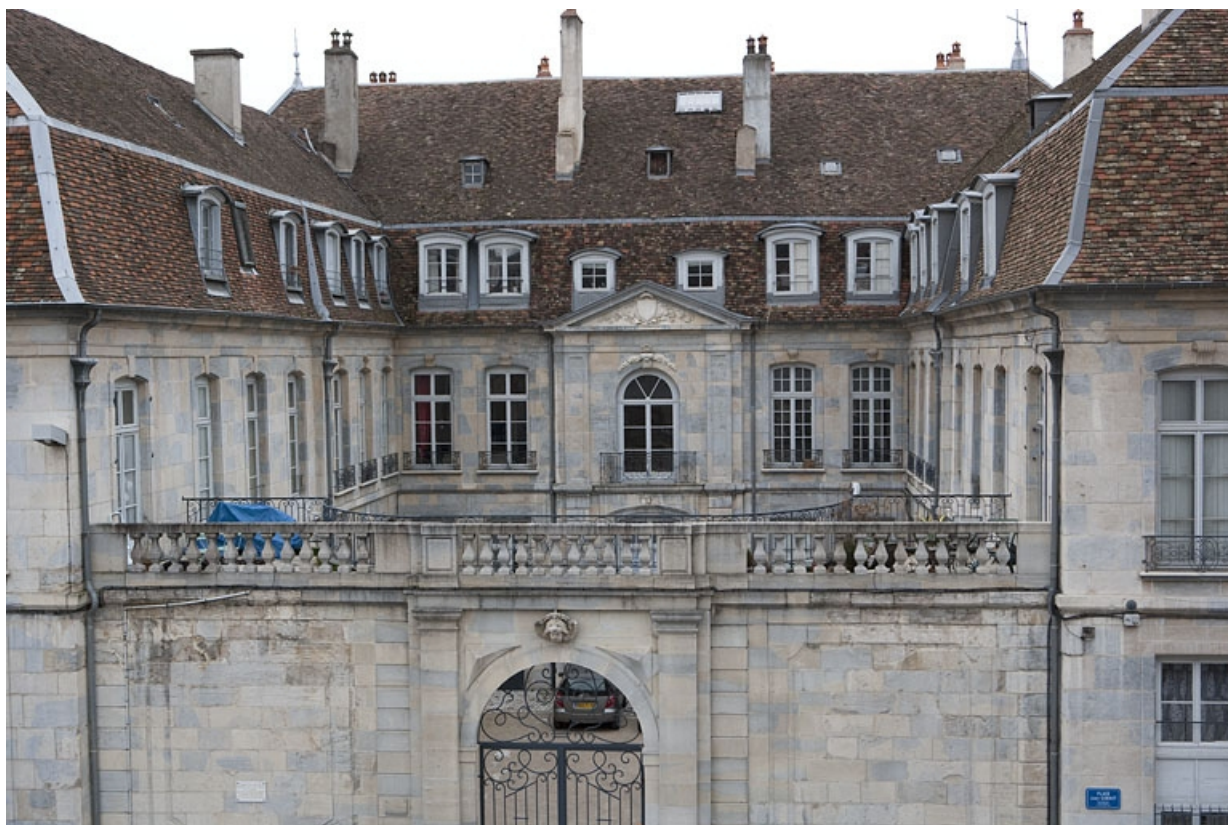
Vue d'ensemble en hauteur de la clôture et du premier étage des bâtiments sur cour.
