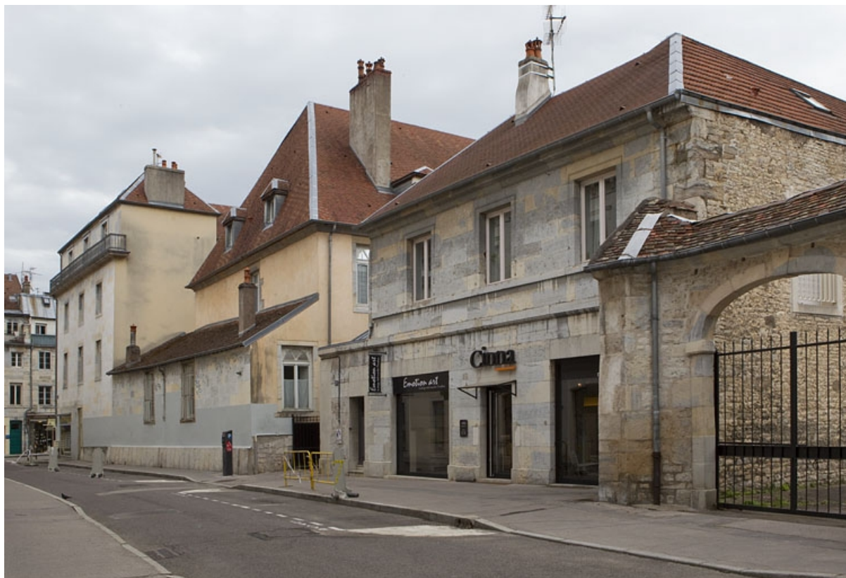
Vue d'ensemble rapprochée des bâtiments depuis la rue de la bibliothèque.
