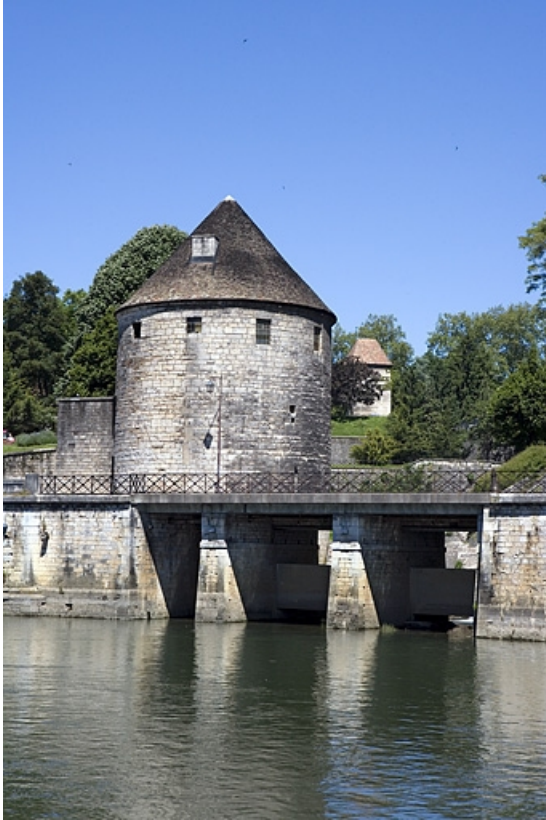
Moulins de la Mouillère (détruits) : débouché du ruisseau dans le Doubs (et tour de la Pelote). 25, Besançon
