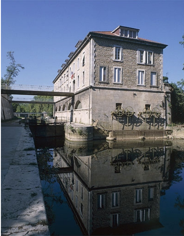
Moulin Saint-Paul de trois quarts droite (depuis l'amont).
