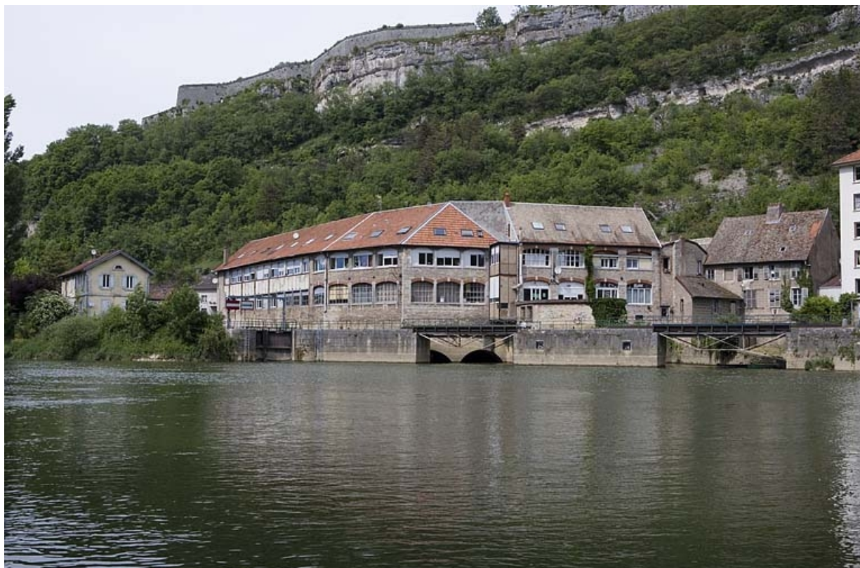
Moulin de Tarragnoz : vue d'ensemble côté rivière, depuis l'amont. 25, Besançon
