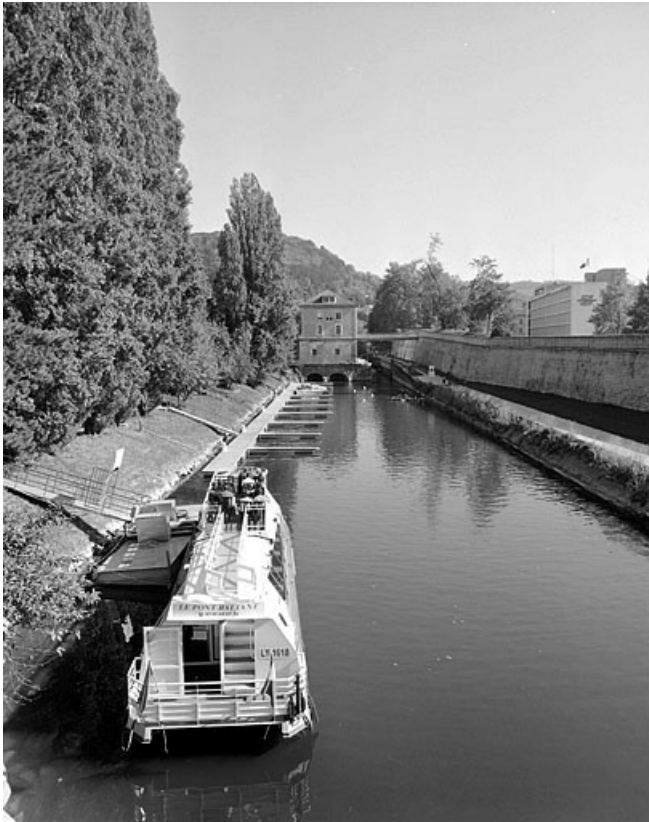
Vue d'ensemble du moulin Saint-Paul, depuis l'aval. 25, Besançon
