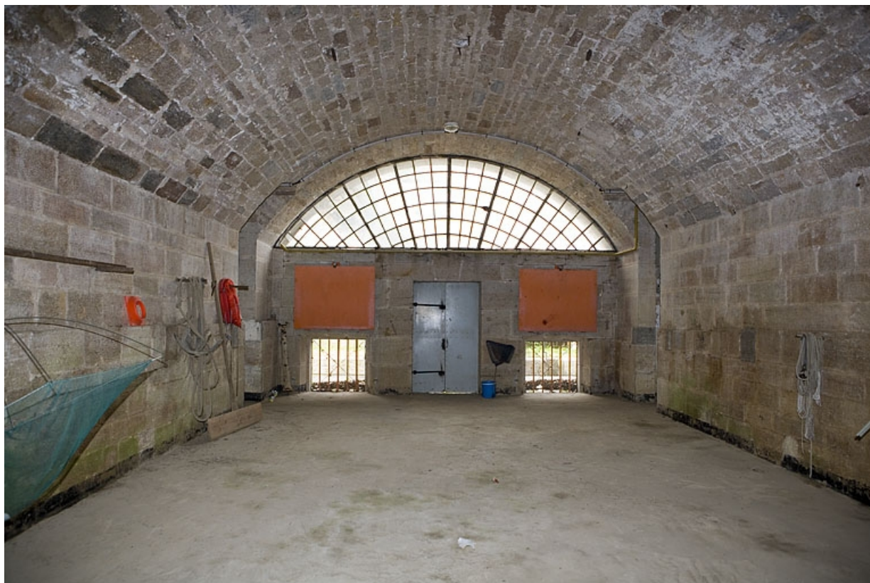
Moulin Saint-Paul : intérieur d'une casemate, à l'étage de soubassement. 25, Besançon
