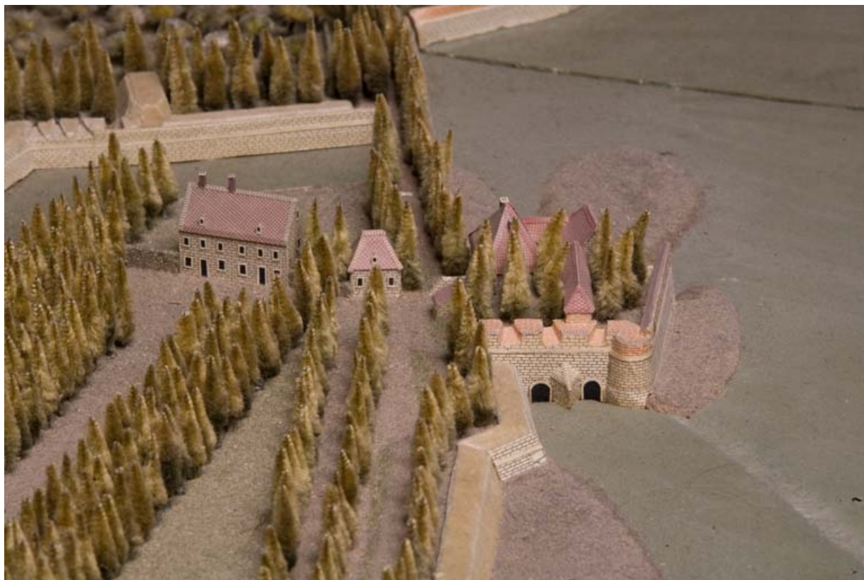
Vue plongeante sur le moulin de la Ville depuis l'amont : détail du plan-relief de Besançon, 1722. 25, Besançon
