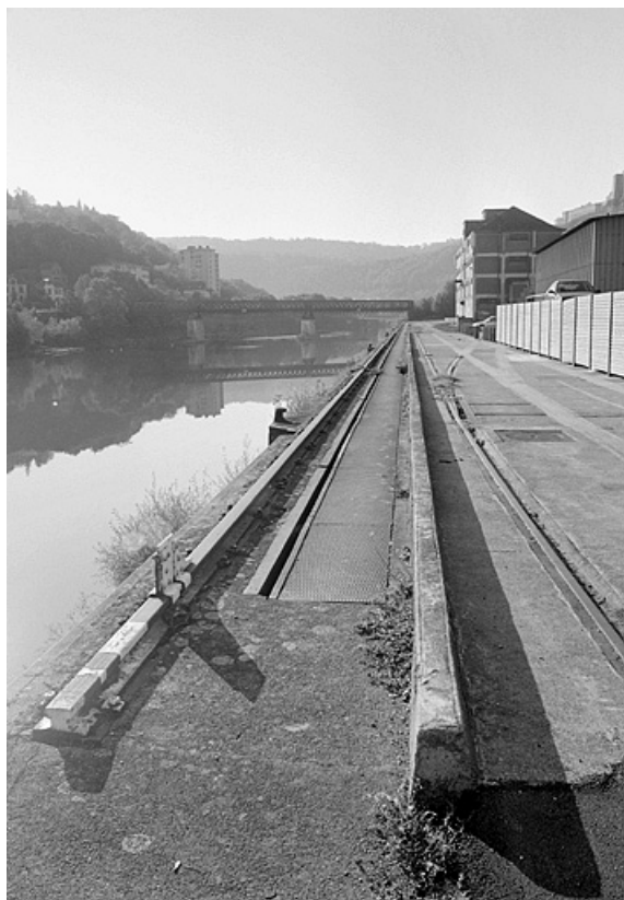
Port fluvial : quai et vestiges de la voie de roulement de la grue mobile, depuis l'aval. 25, Besançon
