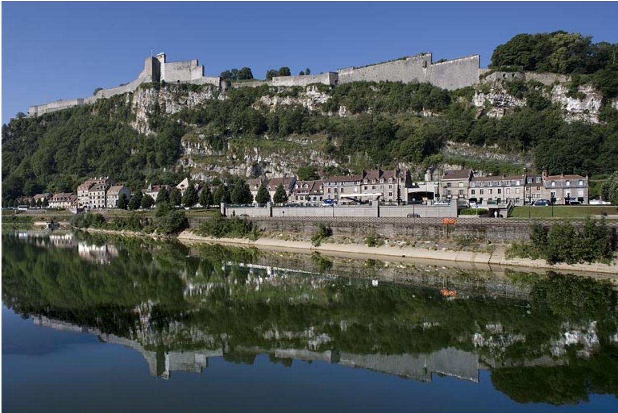
Port de Rivotte : vue d'ensemble de la partie nord, depuis la rive droite. 25, Besançon
