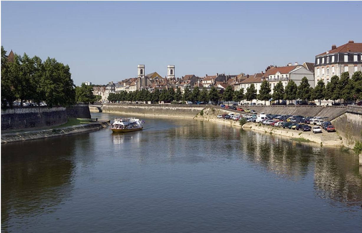
Port de Strasbourg : vue d'ensemble depuis l'amont. 25, Besançon
