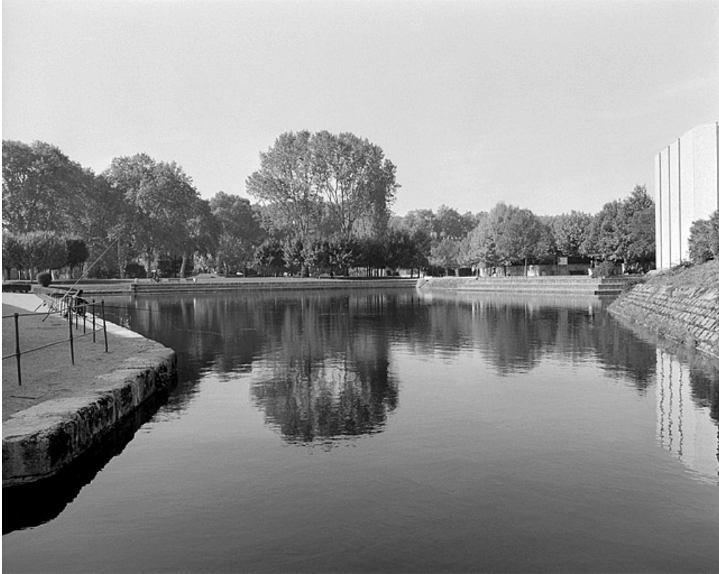
Port de Chamars : le bassin depuis le chenal, au sud-est. 25, Besançon
