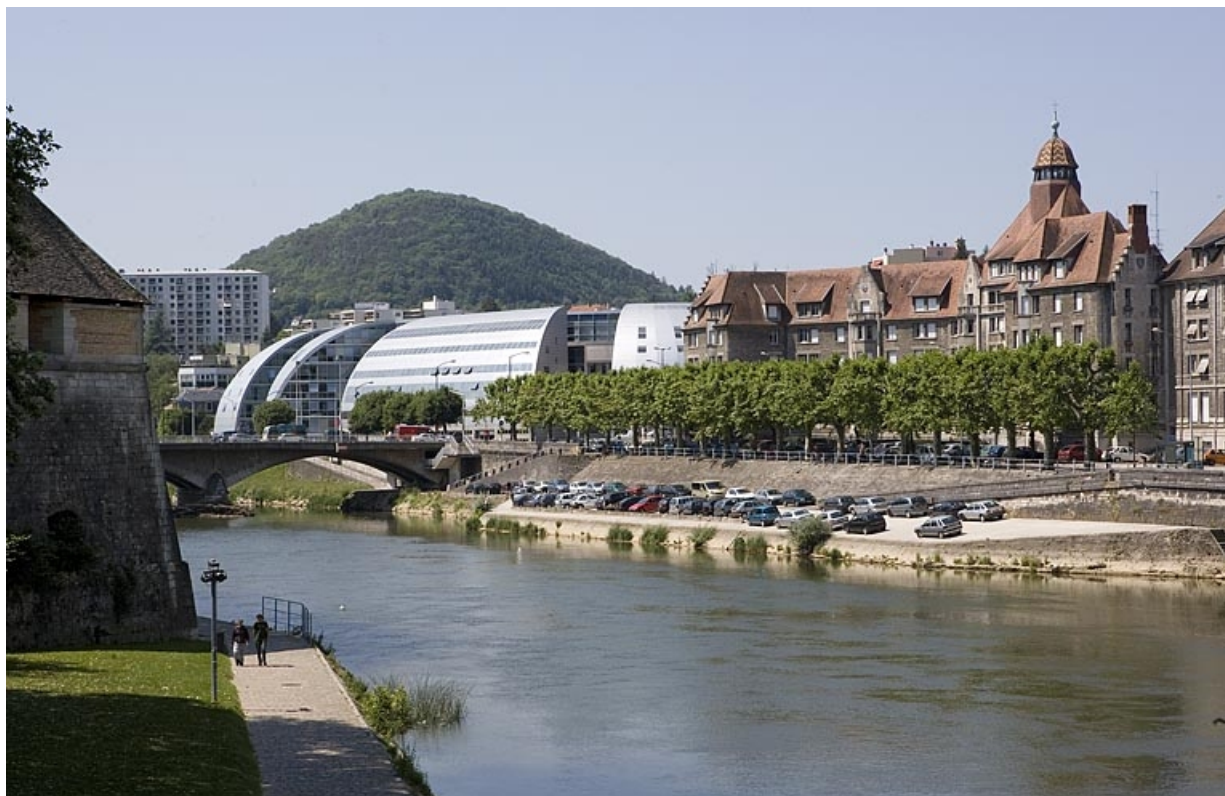
Port de Canot : vue d'ensemble depuis l'amont (rive gauche). 25, Besançon
