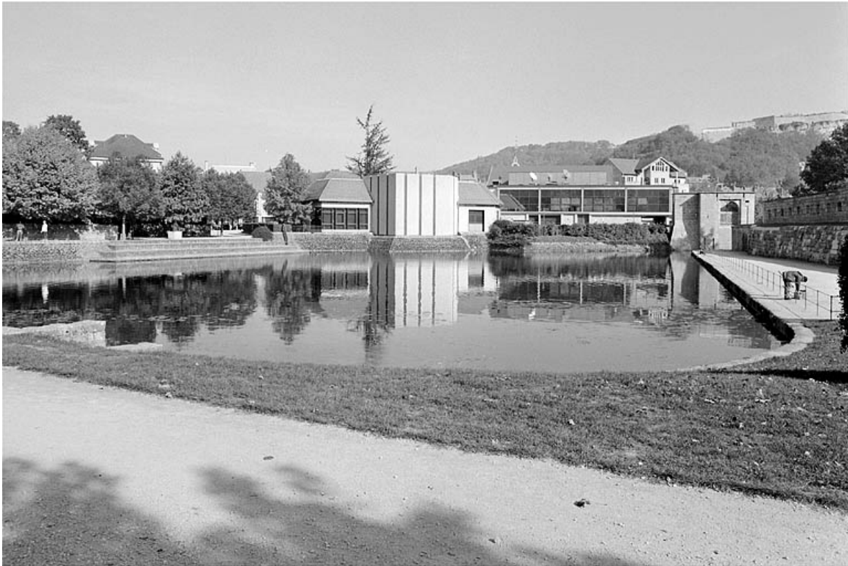
Port de Chamars : vue d'ensemble depuis l'ouest. 25, Besançon
