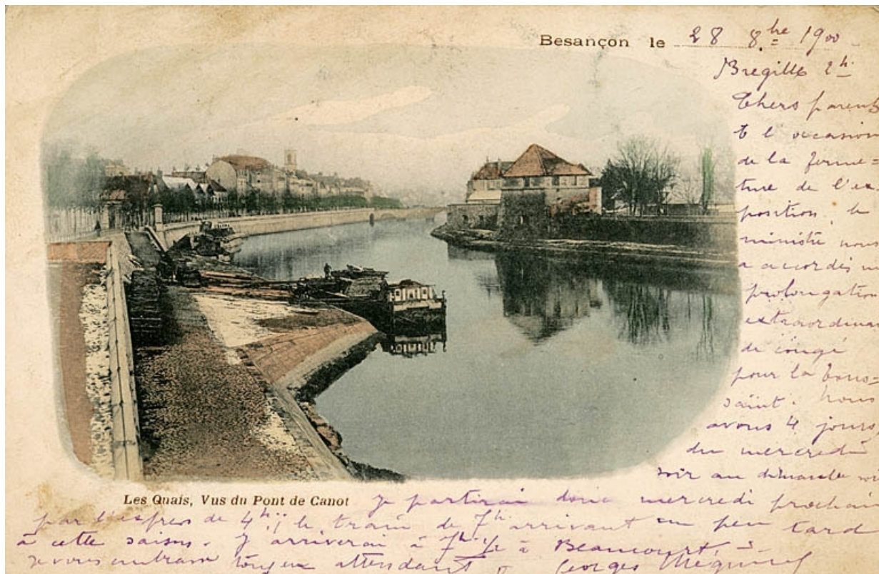
Les Quais, vus du Pont de Canot [et le port de Canot], 4e quart 19e siècle. 25, Besançon
