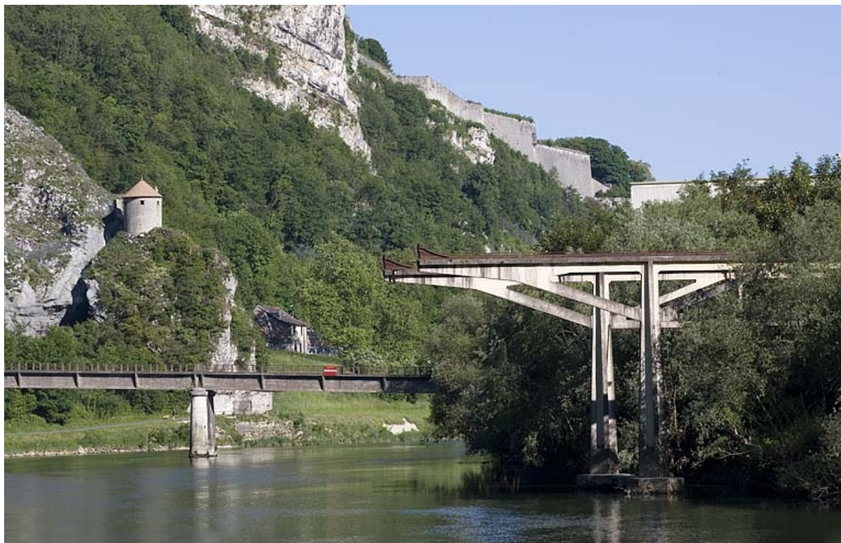
Port de l'usine dite des Soieries puis de la Rhodiacéta : portique en béton du pont roulant. 25, Besançon
