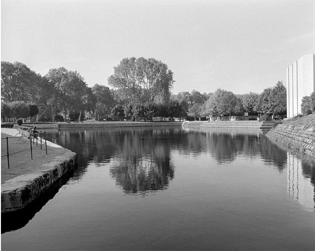
Port de Chamars : le bassin depuis le chenal, au sud-est. 25, Besançon
