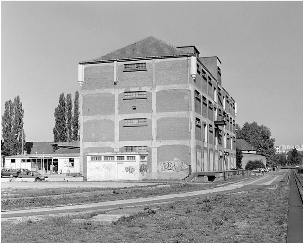
Port fluvial : entrepôt et quai, depuis l'amont. 25, Besançon
