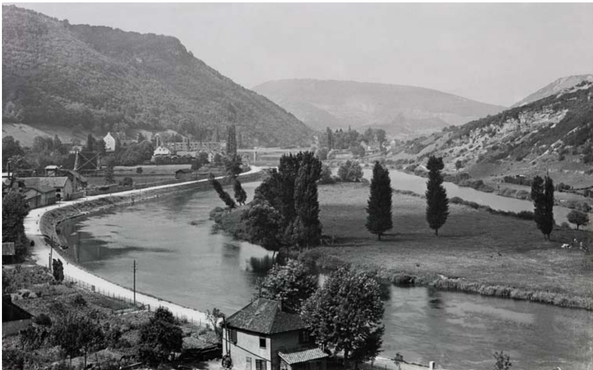
[Vue d'ensemble de la vallée du Doubs à Casamène], 1ère moitié 20e siècle. 25, Besançon
