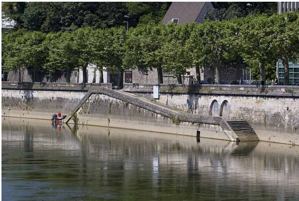
Port Déprez (disparu) : escalier et rampe d'accès à la rivière à son emplacement, depuis l'amont. Les deux baies en arc plein cintre donnaient un accès direct à la rivière en passant sous le quai Veil-Picard.
