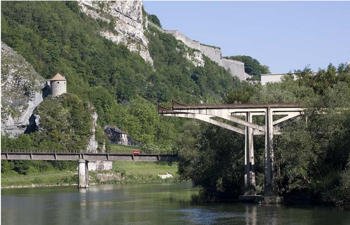
Port de l'usine dite des Soieries puis de la Rhodiacéta : portique en béton du pont roulant. 25, Besançon
