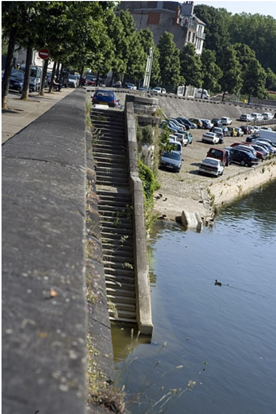
Port de Strasbourg : escalier et rampe d'accès à la rivière. 25, Besançon
