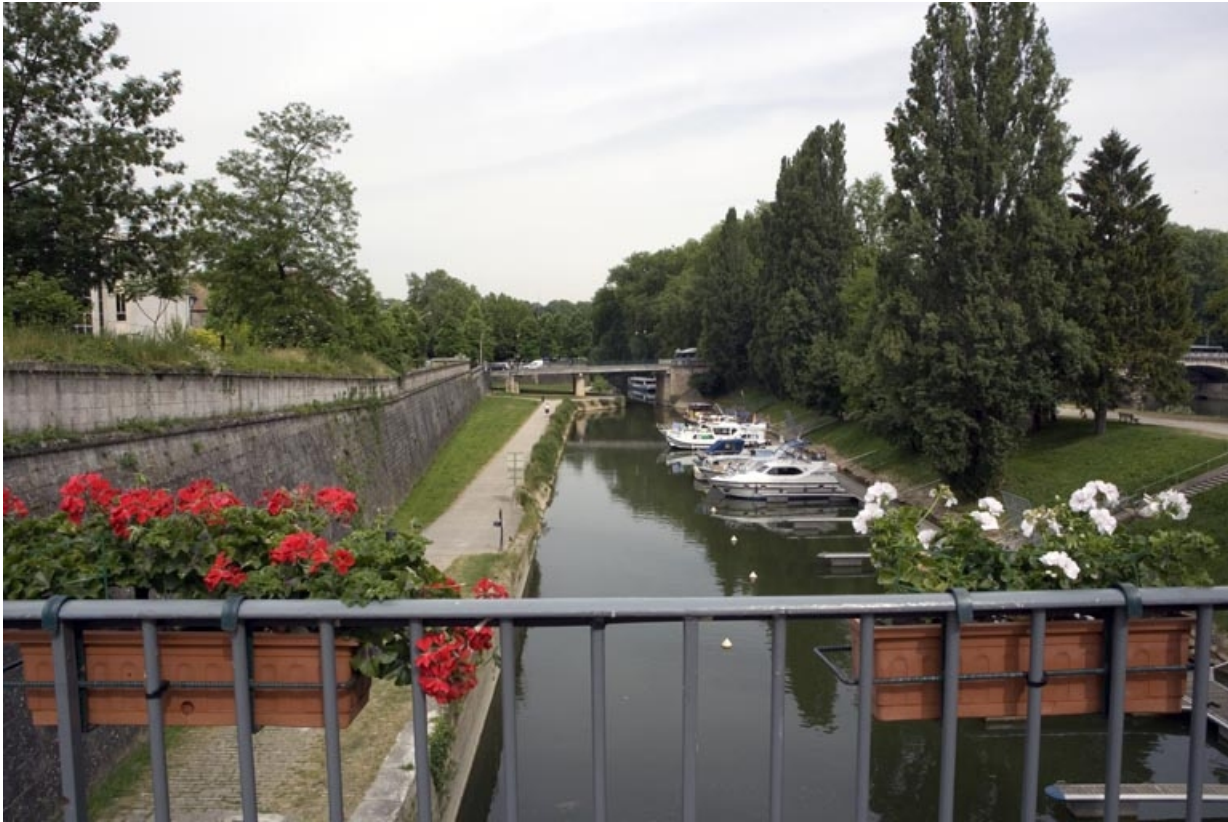
Port (halte nautique) de Saint-Paul : vue d'ensemble depuis l'amont. 25, Besançon
