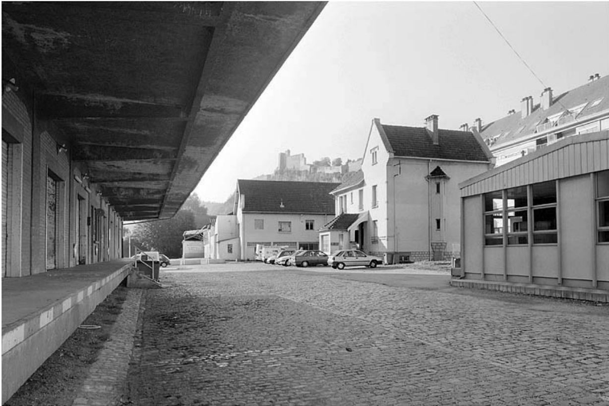
Port fluvial : vue d'ensemble de la cour, en 2003. Les entrepôts des particuliers, au fond, ont été démolis en 2004. 25, Besançon
