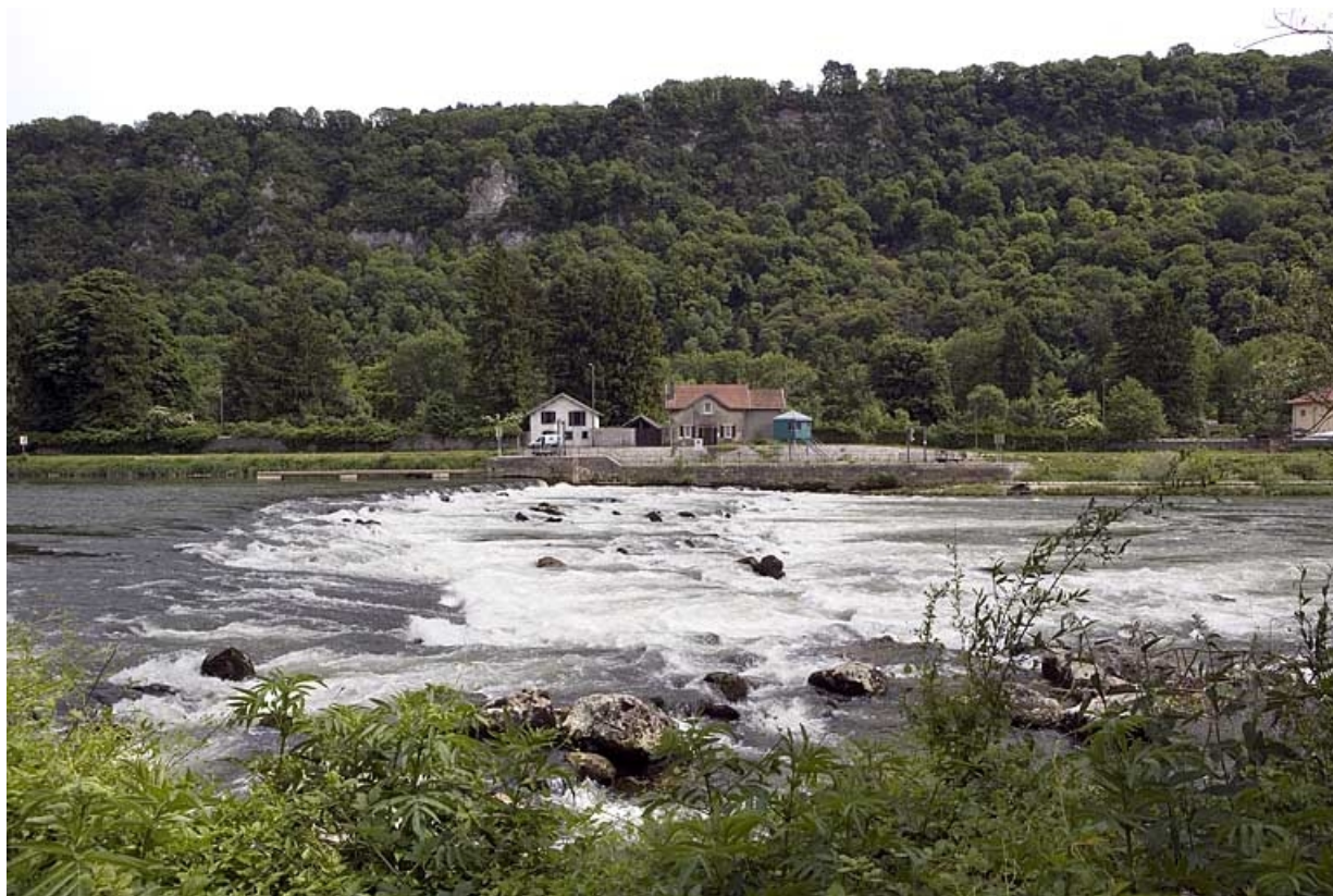
Vue d'ensemble depuis l'extrémité du barrage, rive droite.
