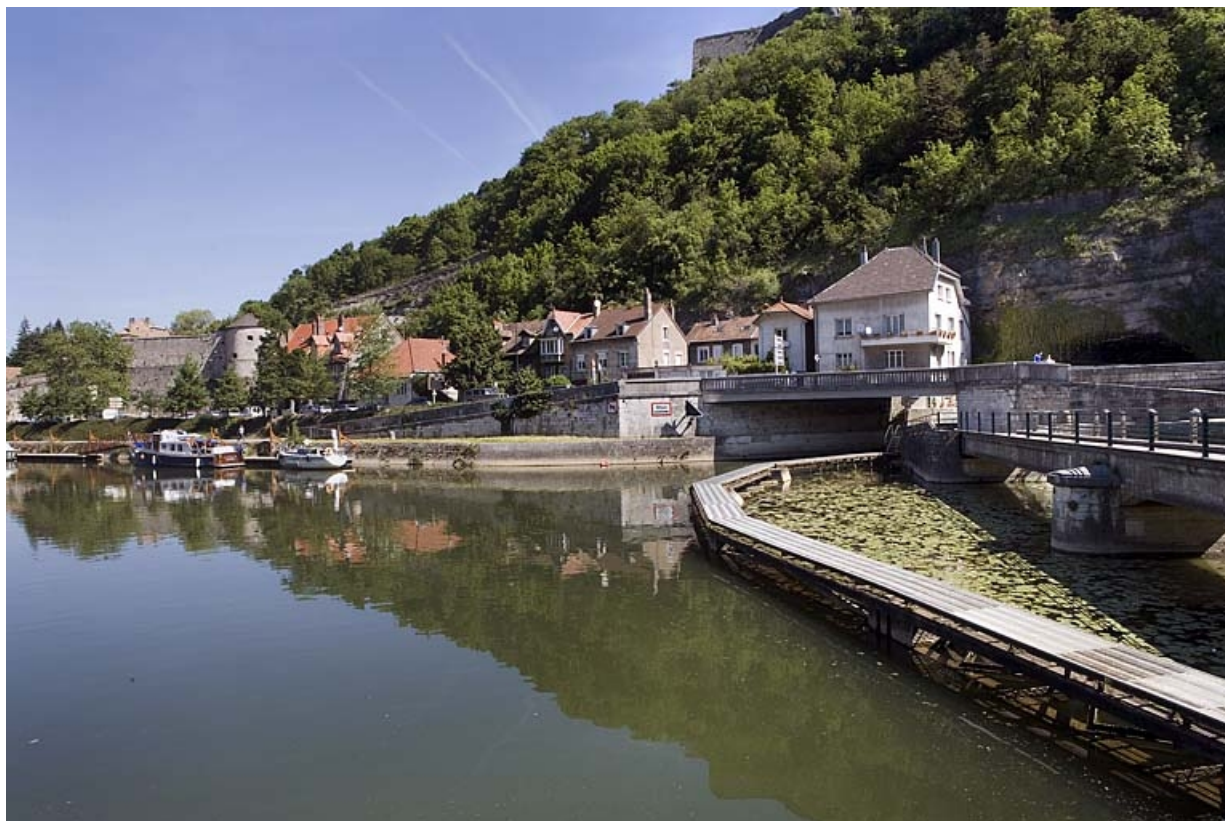
Debouché de l'écluse n° 50, pont routier et estacade, depuis l'écluse n° 51. 25, Besançon Faubourg Tarragnoz, lieudit : îlot Tarragnoz
