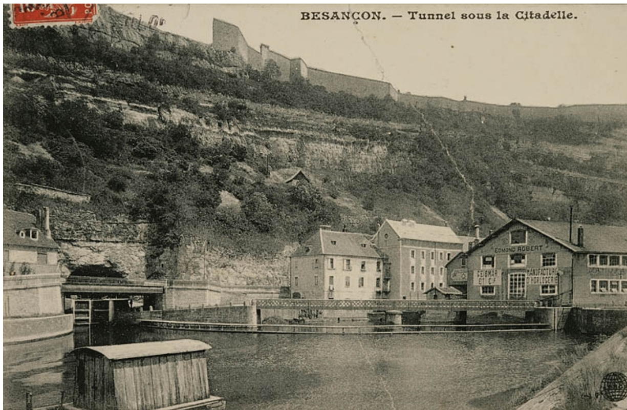
Besançon. - Tunnel sous la Citadelle [depuis l'île de la maison d'éclusier n° 51], décennie 1890 ou 1900.
