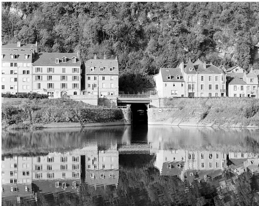
Vue d'ensemble de la porte de garde et de l'extrémité amont du tunnel.
